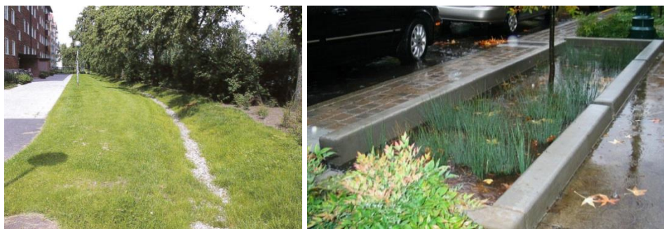
Figur 10. Exempel på hur ett gräsklätt svackdike och en Rain Garden kan se ut (Stahre, 2004 samt Jefferson County, 2016)
