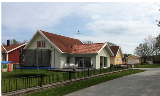
Mellringe - Småskalig blandning av 1- och 2-våningshus.
