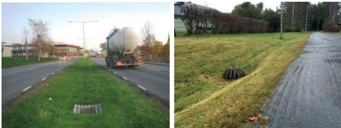
Figur 26. Två exempel på svackdiken. (Svenskt Vatten Utveckling, 2016)
