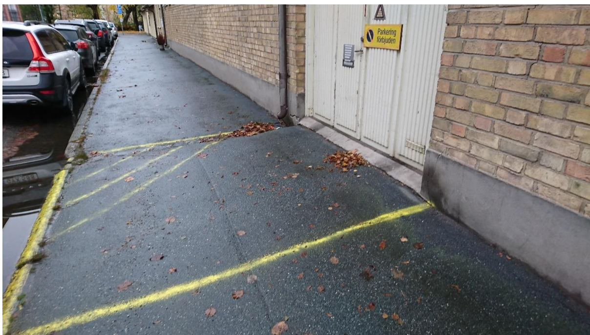
Bild 1; Befintlig byggnad utmed Fridhemsgatan. Byggnaden kommer att rivas.
