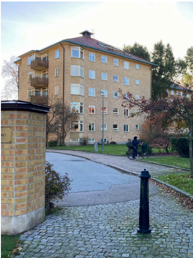
Varierade fasaduttryck i form av burspråk och variation mellan liggande och stående fönsterpost i punkthusens fasader.
