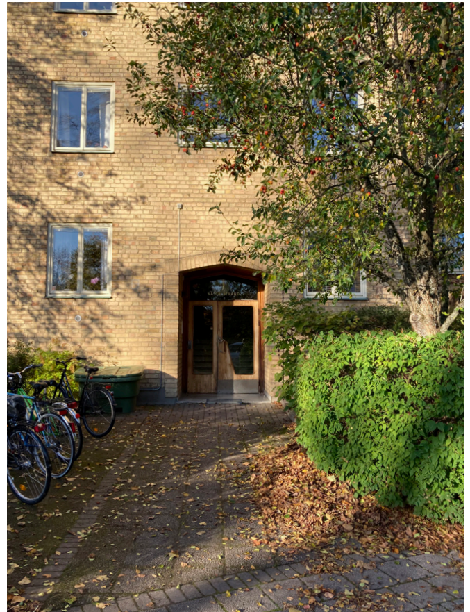
Punkthusens ursprungliga detaljer i form av fönstersättning och portar.
