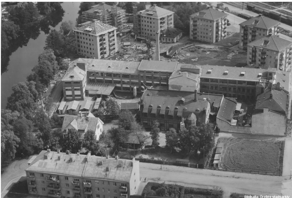
Flygfoto från 1947 med fabriken och de nya punkthusen i park.
