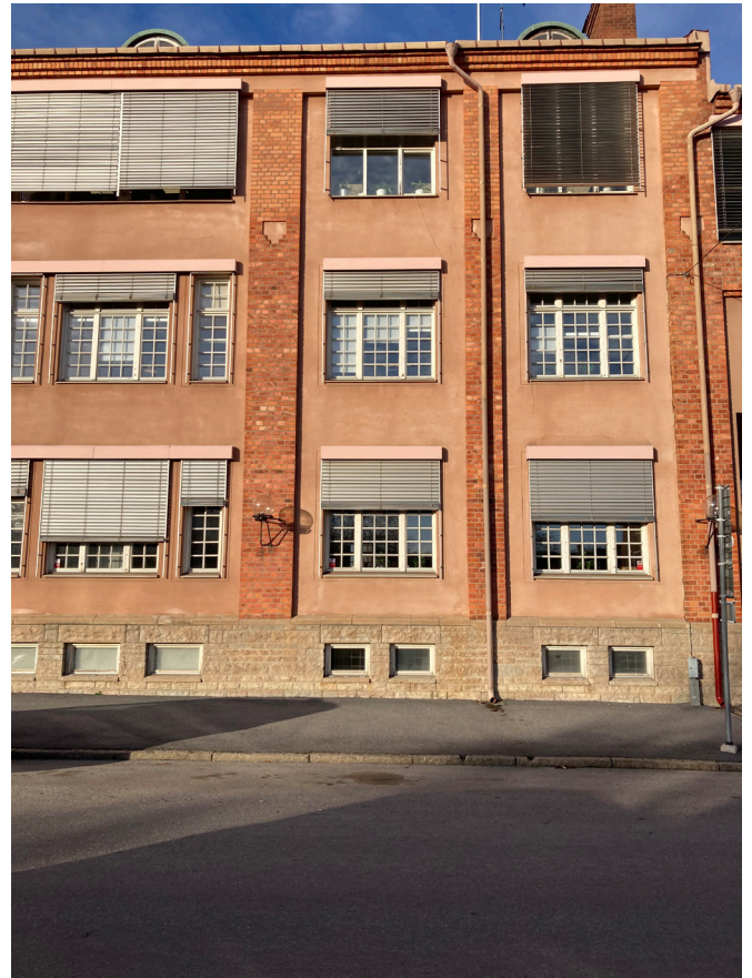
Naturstenssockel och putsad fasad med tegellisener på Ånstagatan.
