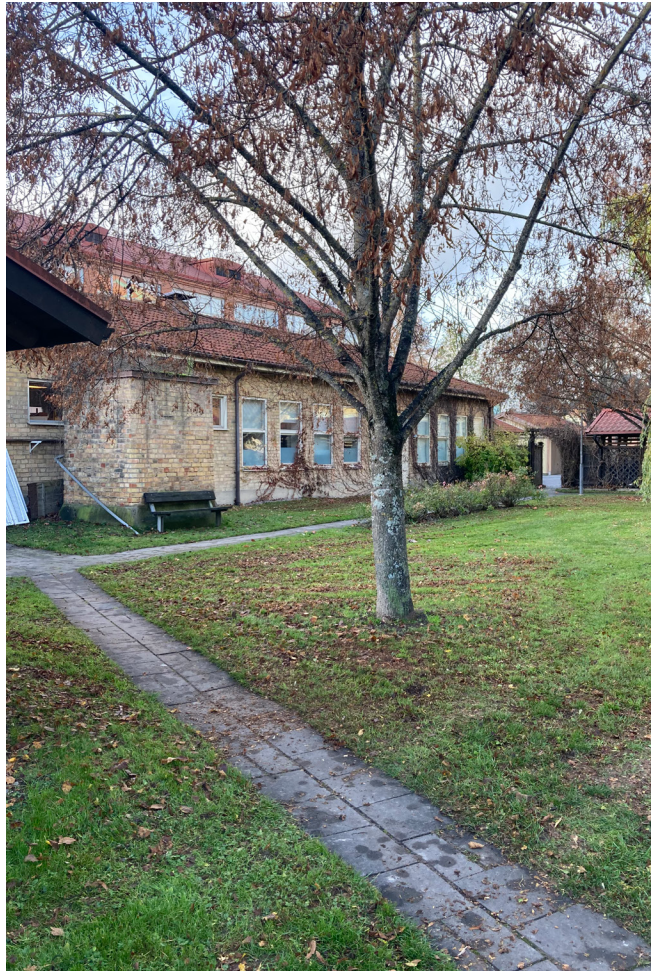
Baksidan av byggnaden, mot parken.
