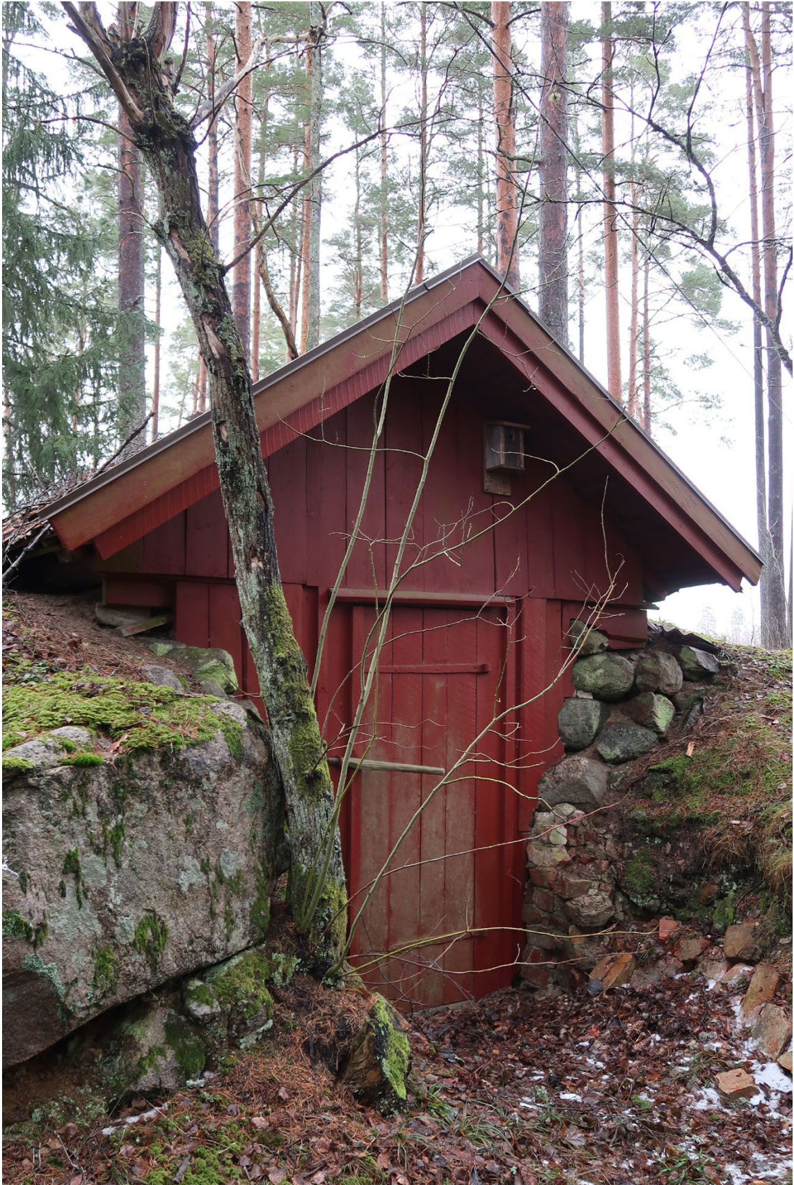
Jordkällaren sedd från sydväst. Framsidan har renoverats i modern tid, men dörrens gångjärn är ålderdomliga och liknande sitter på den inre dörren.
