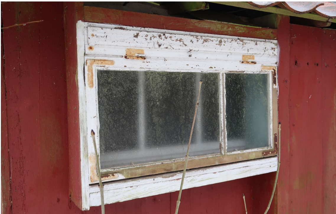
Handsmidda hakgångjärn och återbrukade fönster är värdebärande delar av brygghuset vid Nyttorp.
