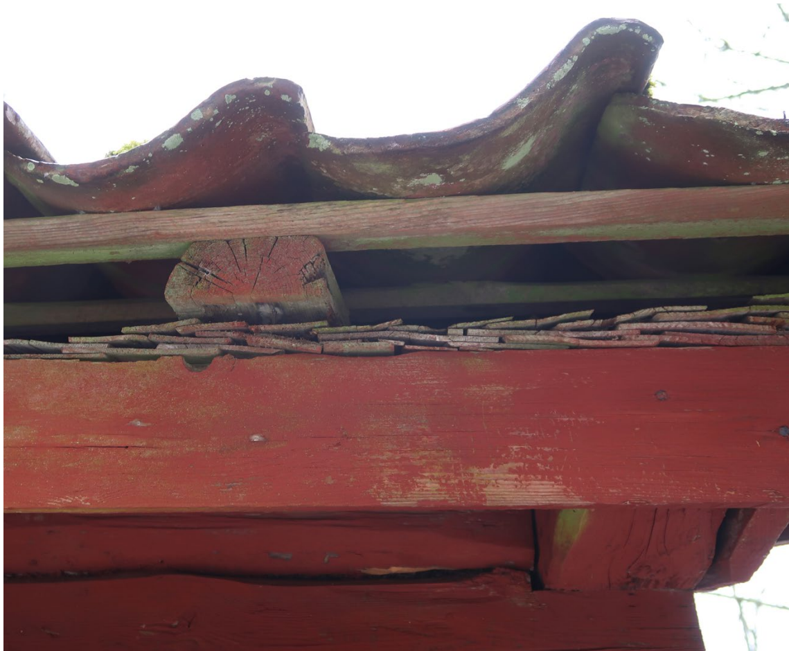
Handslaget enkupigt lertegel som värdebärande del av bostadshuset vid Trädgårdstorp.
