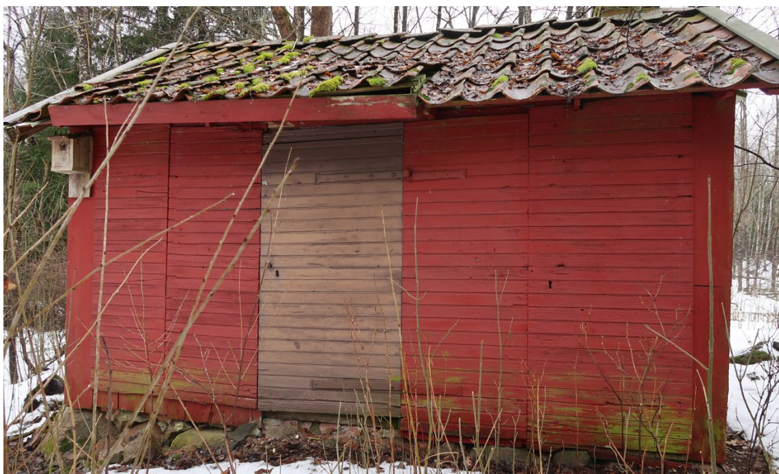
Östra fasaden har partier med liggande plank som kan vara återbrukade dörrar och panel från annat hus.
