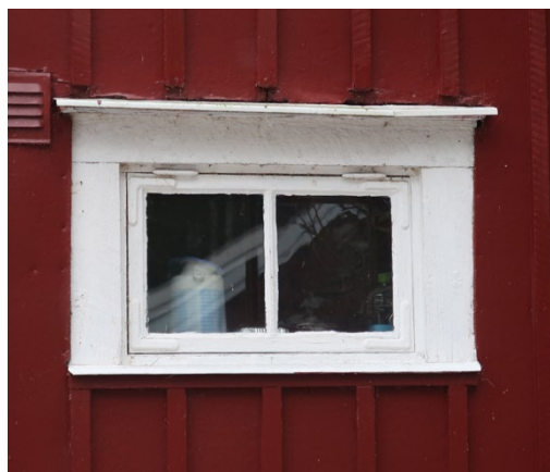
Liggande fönster med gångjärn i överkant.
