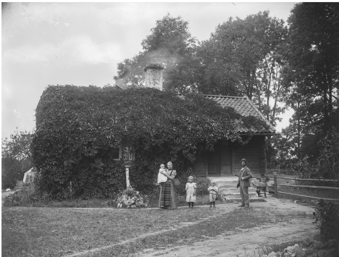
Okänd torpstuga vid Myrö under 1800-talets slut. Byggnaden är en enkelstuga i dimensioner snarlika de i bostadshuset på Trädgårdstorp (Örebro läns museum).
