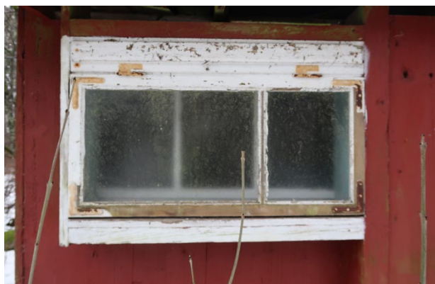
Västra fasadens fönster är liggande med gångjärnen i överkant.
