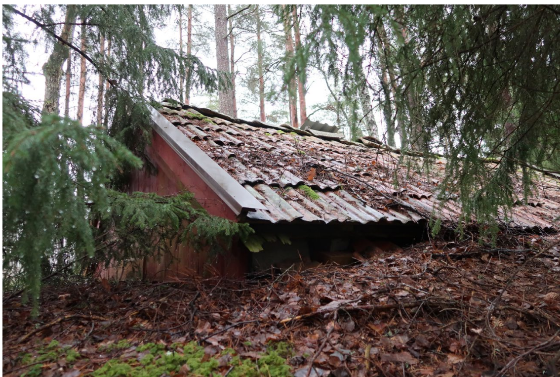
Jordkällaren sedd från nordväst. På taket ligger trekupigt lertegel. Ett ovanligt taktegelformat.
