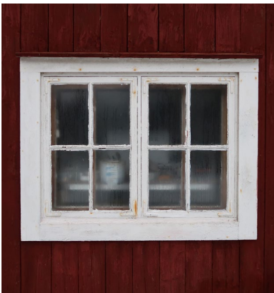
Majoriteten av uthuslängans fönster har fönsterbågar med fyra rutor delade av spröjs.
