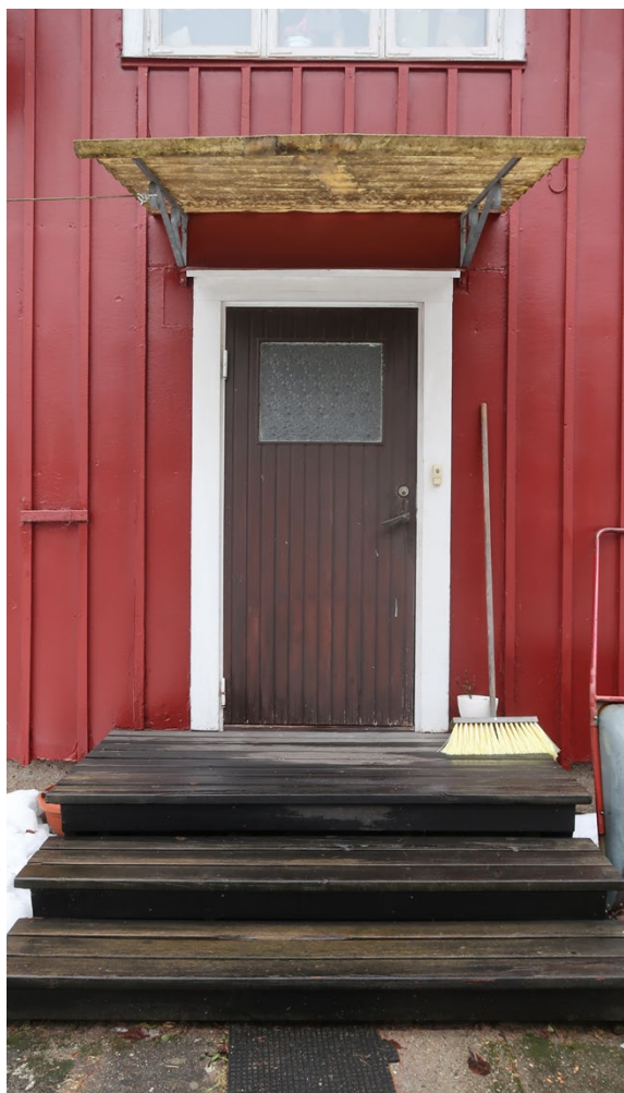
Nyttorps entré i söder.
