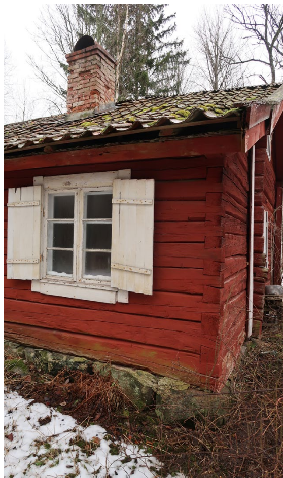
Timmerstommen på bostadshuset vid Trädgårdstorp uppvisar minst tre olika tillblivelseperioder. Den ursprungliga enkelstugans bottenvåning är äldst, uppförd i rundtimmer. Denna har senare kompletterats med en vindsvåning där timret huggits rakare. Mot baksidan i norr finns ytterligare en variant på timring med en mycket släthuggen variant.
