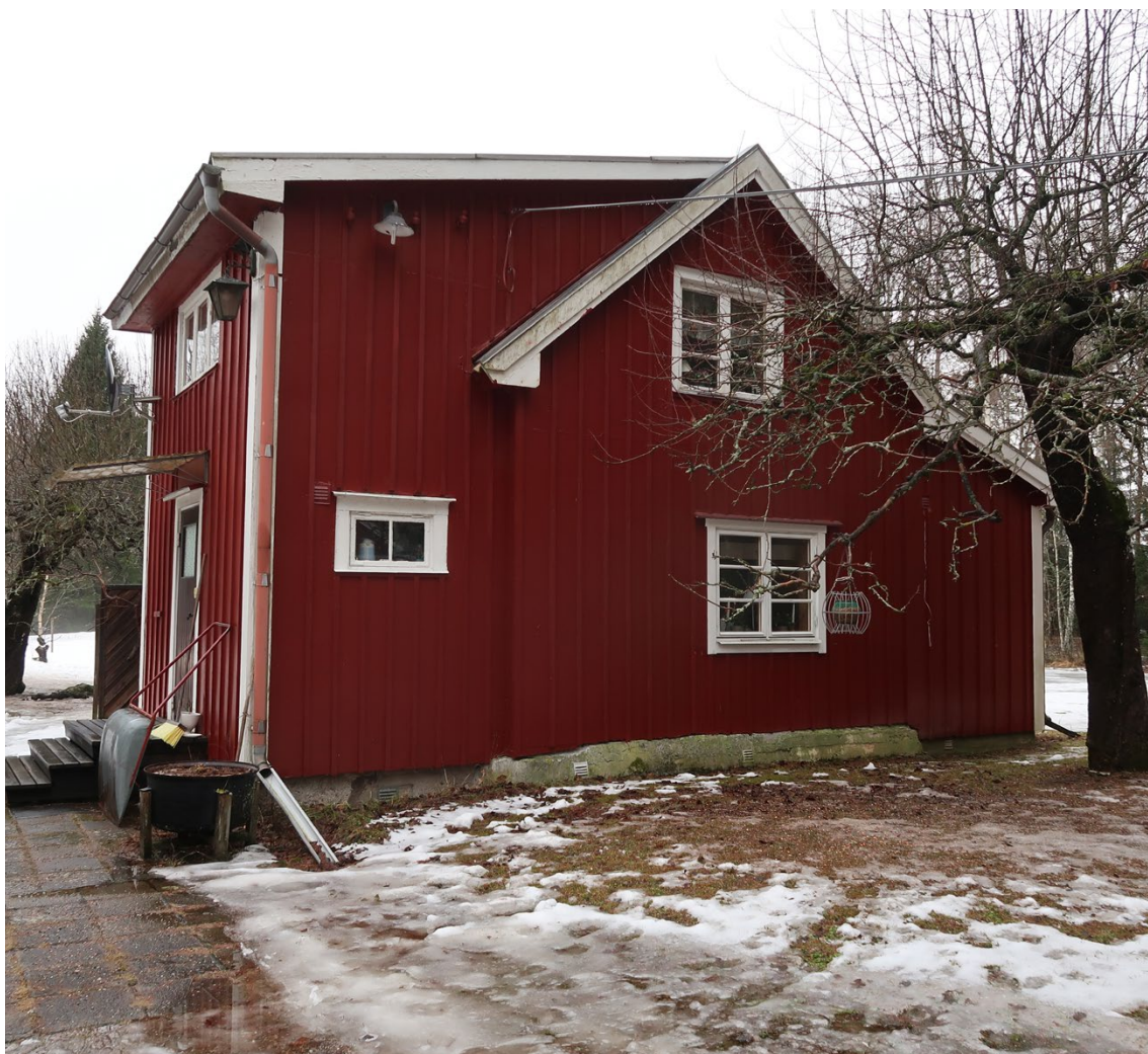
Bostadshuset i Nyttorp från öst. Originalbyggnaden kan skådas mellan södra och norra utbyggnaderna.
