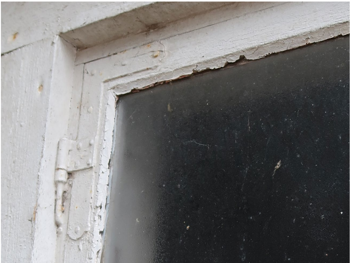
Ålderdomliga handsmidda hakgångjärn och fönsterbeslag är värdebärande återbrukade delar av uthuslängan vid Nyttorp.
