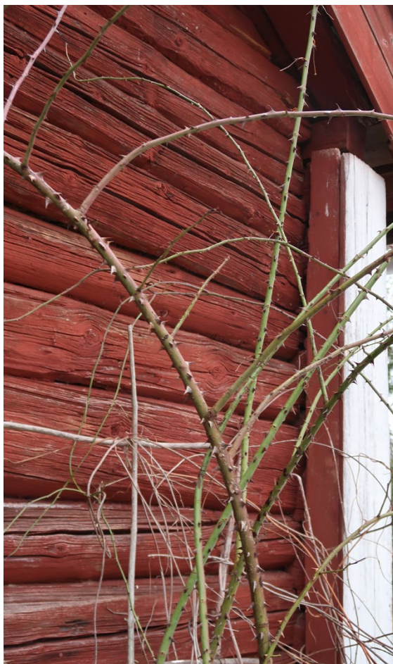
Timmerstommen på bostadshuset vid Trädgårdstorp uppvisar minst tre olika tillblivelseperioder. Den ursprungliga enkelstugans bottenvåning är äldst, uppförd i rundtimmer. Denna har senare kompletterats med en vindsvåning där timret huggits rakare. Mot baksidan i norr finns ytterligare en variant på timring med en mycket släthuggen variant.
