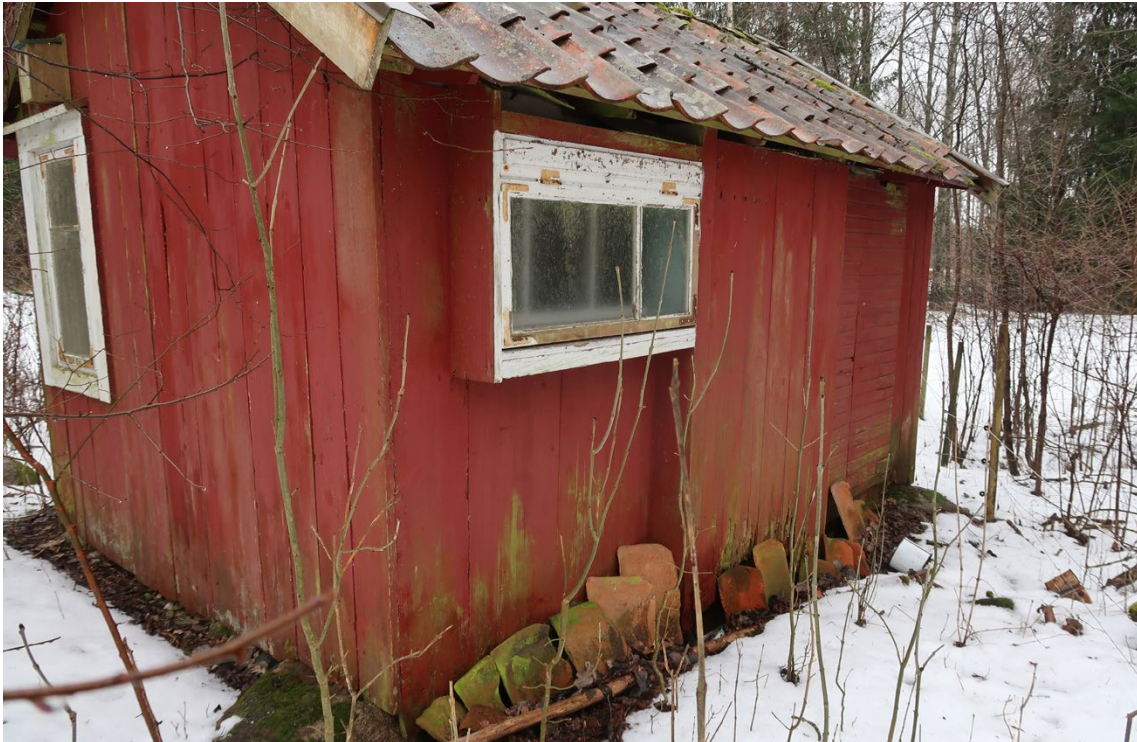
Norra och västra fasaden på brygghuset.
