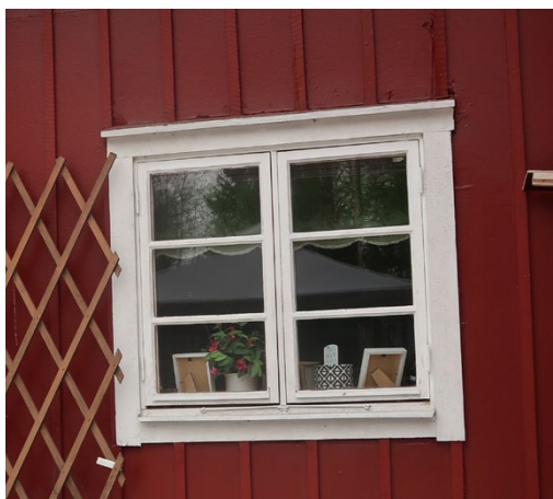
Sexdelade fönster utmed originalbyggnaden.
