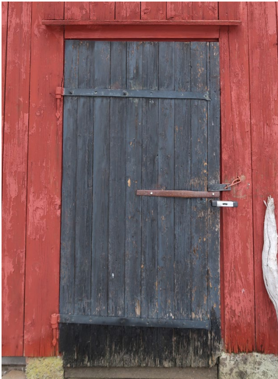
Västra dörren med stående plank och hakångjärn.
