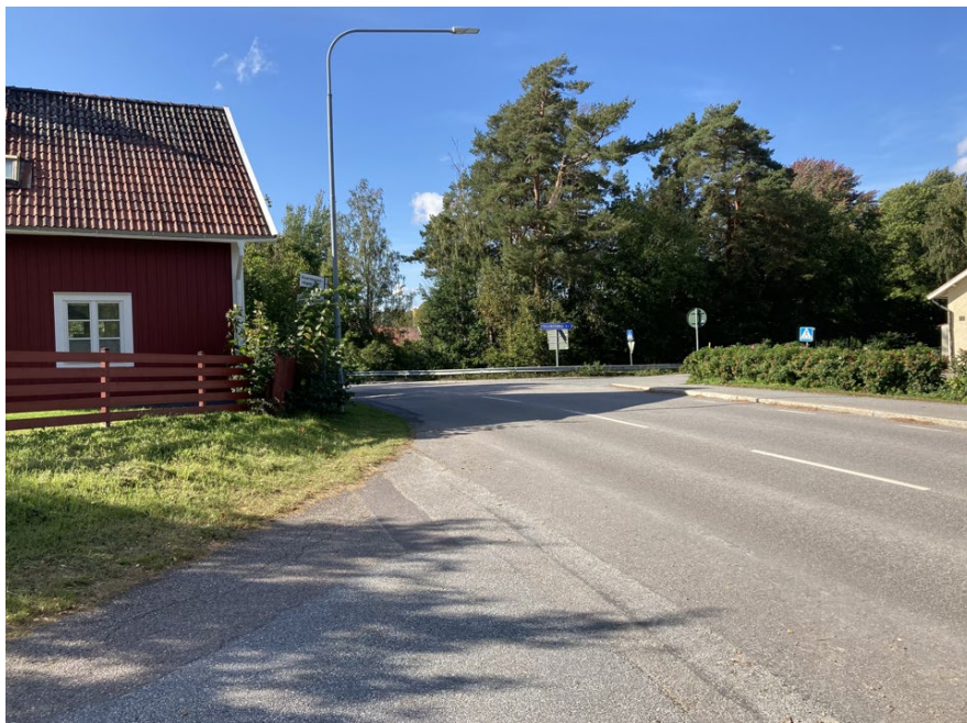
Vy västerut vid korsningen Kvarntorpsvägen/Gamla Arbogavägen. Sikten är blockerad och korsningen bedöms som ett sämre alternativ än att använda befintlig utfart direkt till Gamla Arbogavägen.
