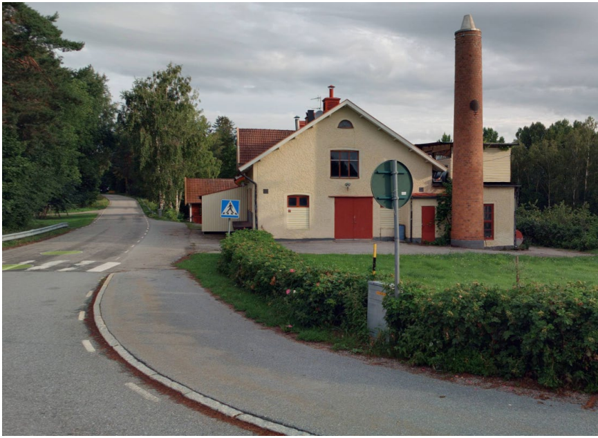
En annan äldre industribyggnad vid infarten till Glanshammar på andra sidan Gamla Arbogavägen.
