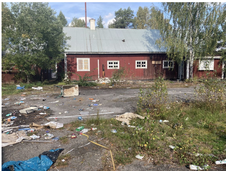
Samma byggnad som ovan sedd från mitten av planområdet. Perspektiv mot norr.
