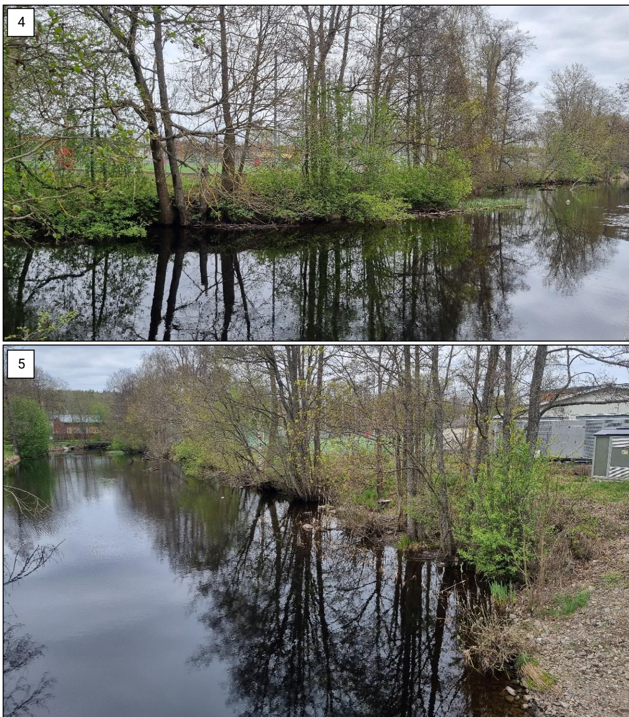
Figur 6-8 – Foton längs planområdets södra gräns. Pågående erosion kan ses i form av lutande träd, lokala vikar och exponerade rötter. I undre figuren kan befintligt erosionsskydd mot bron ses.
