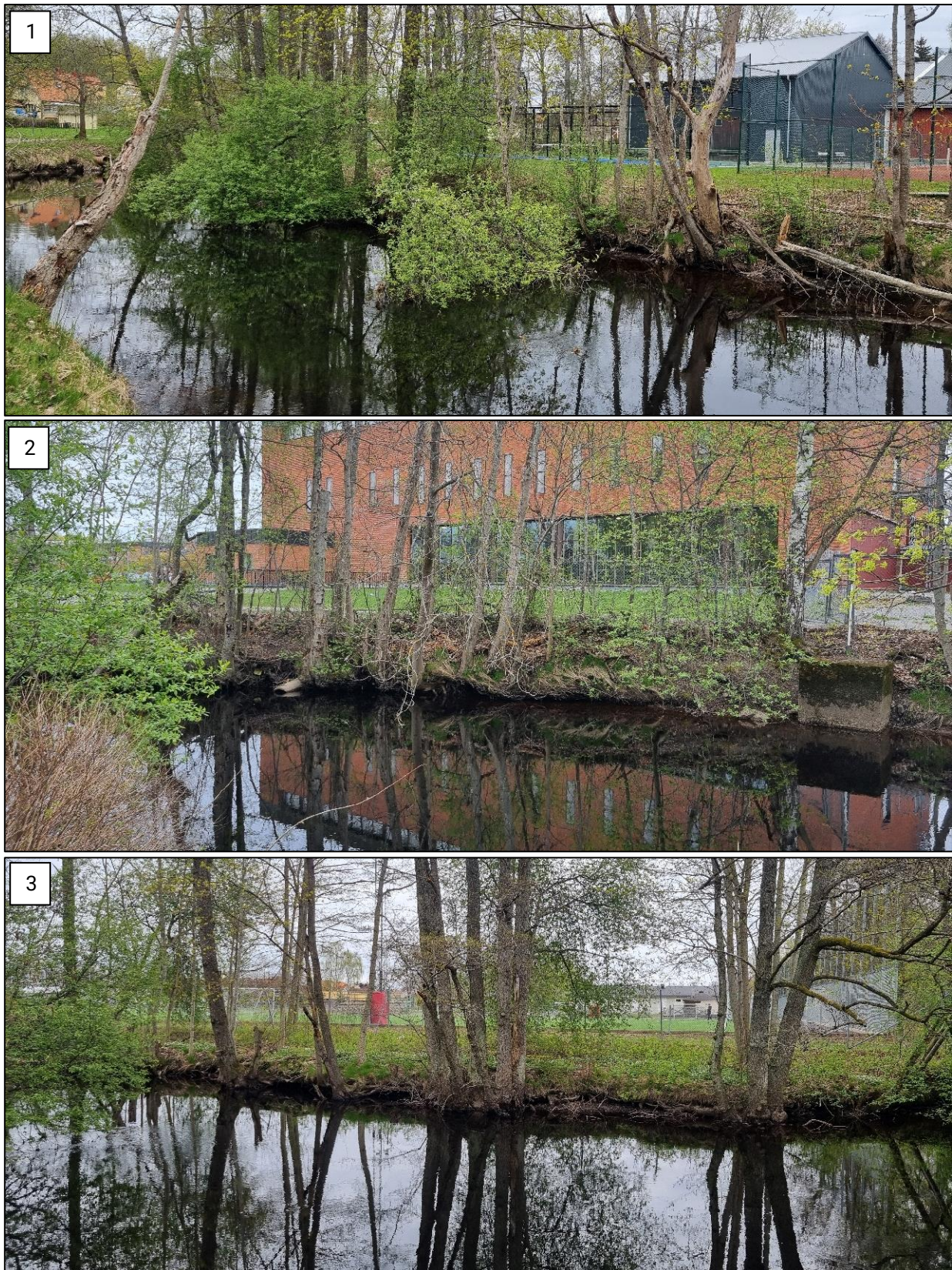
Figur 6-7 – Observerad pågående erosion i form av exponerade rötter, lutande träd samt vikar vid släntrönen.
