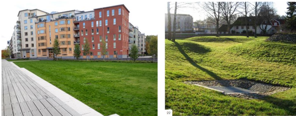
Figur 9: Exempel på översvämningssyta/torrdamm (Foton: Norconsult och Malin Engström, Växjö kommun).
