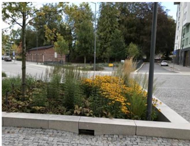
Figur 7: Exempel på nedsänkt regnbädd (Foto: Norconsult) samt principskiss för utformning av regnbädd (VA-guiden).
