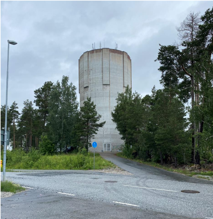
Vattentornet norr om planområdet sett från söder.
