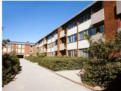
Flerbostadshus under 1970-talet. På bilden syns panelpartier och gröna fönstersnickerier. De ursprungliga balkongfronterna finns kvar. I fönsten syns en överbyggd gång. Källa: Digitalt museum.
