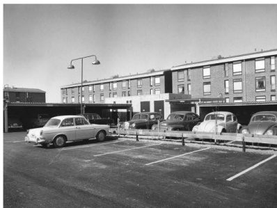
Parkeringsplatser med garagelängor 1960-tal. I bakgrunden syns bostadshusen med sin regelbundna fasaduppbbyggnad. Källa: Digitalt museum.
