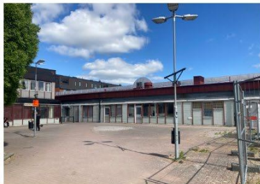
Centrumbyggnadens västra fasad och framförvarande torg. Centrumbyggnaden har en oregelbunden fasaduppbyggnad med fönster i förband. Den samspelar i viss mån med fritidsgården.
