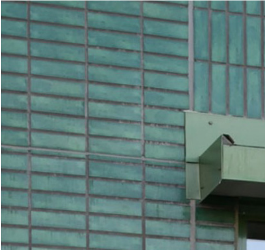
Entréplanen får ett grönglasaerat tegel för att öka motståndskraft från yttre åverkan.
