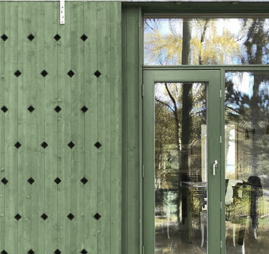
Porten till innergården använder träpanel med hålmönster.
