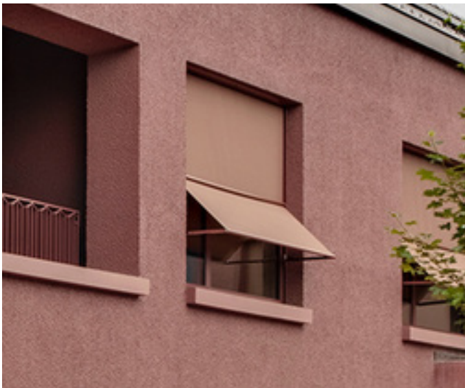
Solavskärmning i fasad
