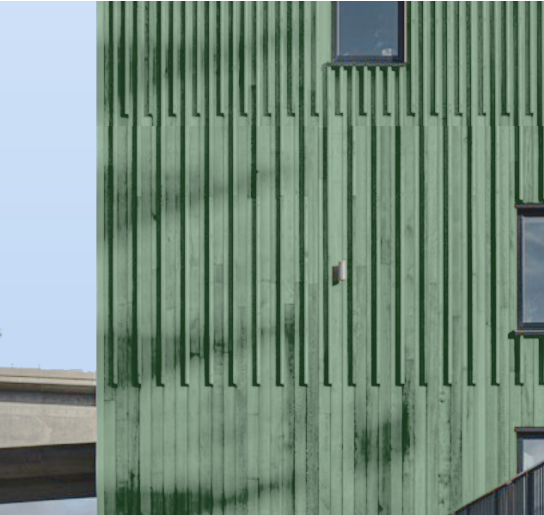
Träpanel med täcklock i varierad täckning för att skapa mönster i fasaden.
