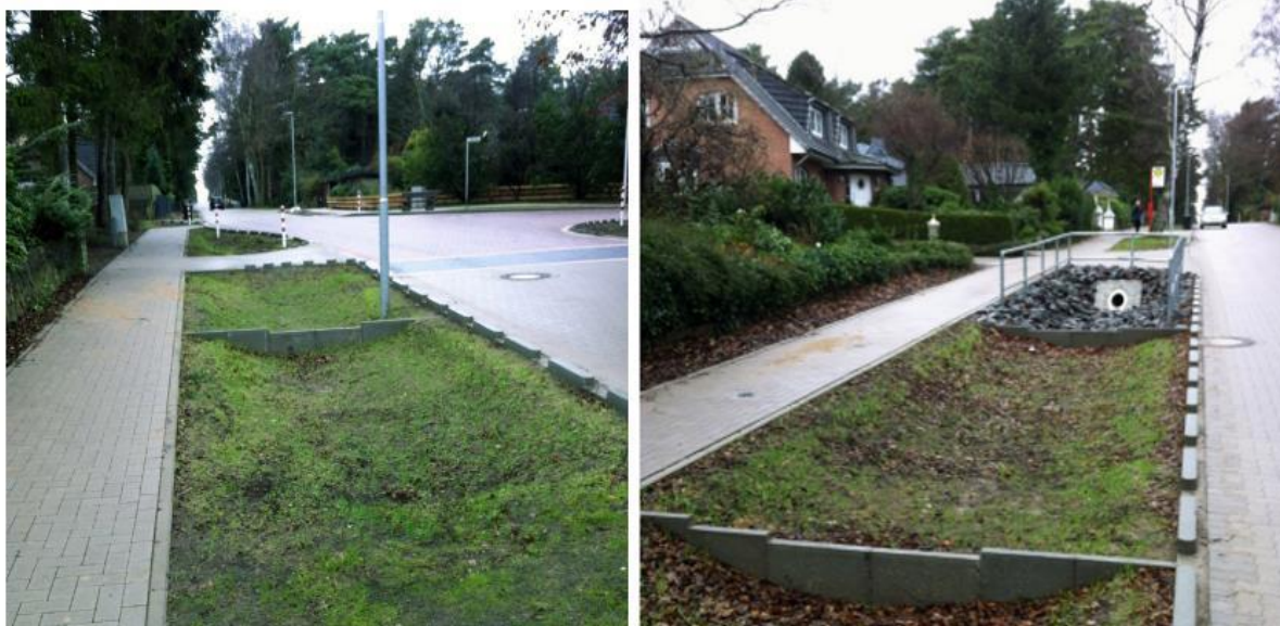
Figur 33. Princip för dikessektioner (foto: WRS).
