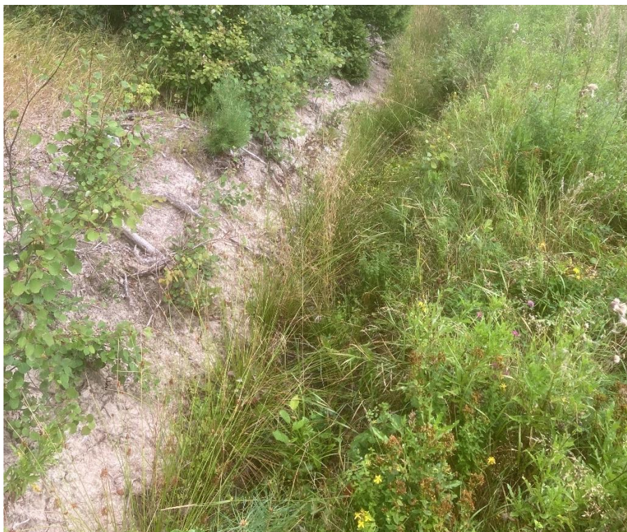
Figur 19. Bild A: Avskärande dike längs med södra planområdesgränsen, vilket även mätts in.
