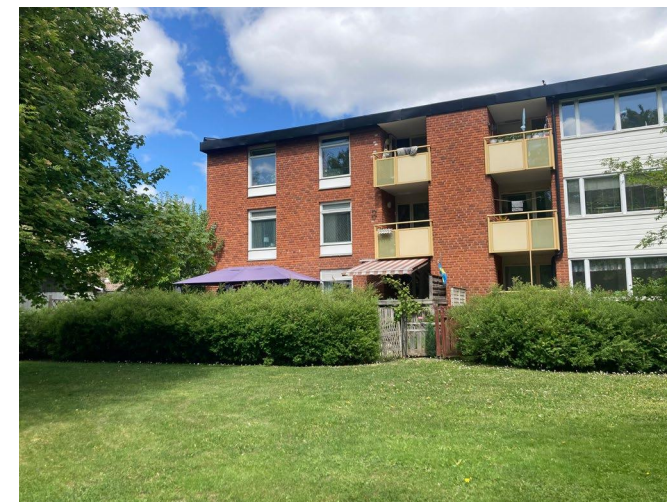
Relativt välbevarat flerbostadshus. Byggnaden har nya balkongfronter. Fönstren markeras med bröstning i skivmaterial. Avbrott i fasaden skapas med fält i panel och fönster i förband.
