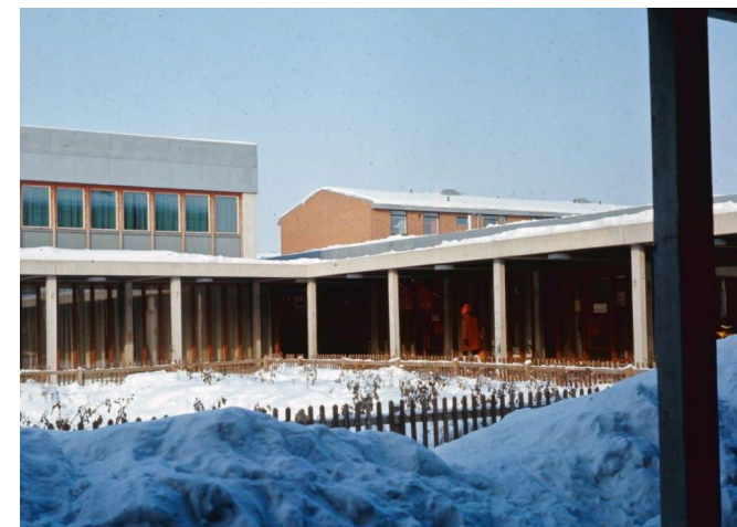
Föreningsgården i vinkel med centrumbyggnaden. De grå kulörerna kontrasteras med glasad bottenvåning och fönstersnickerier i trä. Källa: Örebro stadsarkiv.
