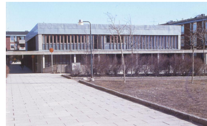
Fritidsgårdens ursprungliga uppförande, västra fasaden.
