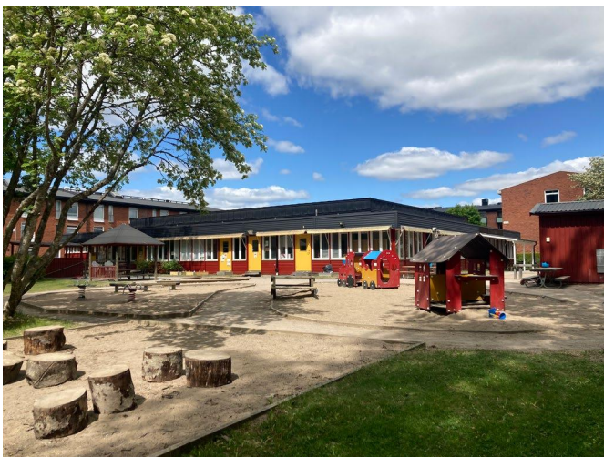
Tidstypisk förskolebyggnad. Byggnaden har flackt tak med sarg och fönster i förband. I området finns även ursprungliga skolbyggnader.
