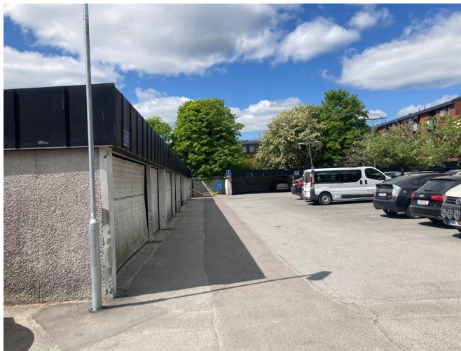
Ursprunglig garagebyggnad med spritputsade väggar och platt tak med sarg. De långsmala och låga garagelängorna är tidstypiska inslag.
