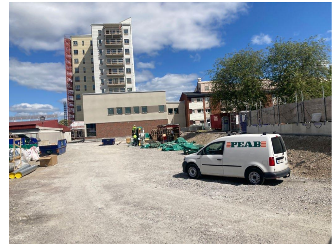
Punkthusets lågdel som flankerar vårdbyggnaden. Sockelvåning i tegel ansluter till områdets karaktäristiska fasadmaterial.
