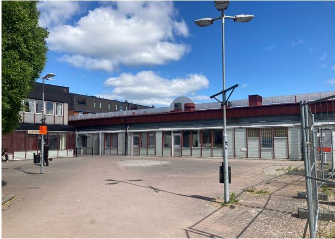
Centrumbyggnadens västra fasad och framförvarande torg. Centrumbyggnaden har en oregelbunden fasaduppbbyggnad med fönster i förband. Den samspelar i viss mån med fritidsgården.
