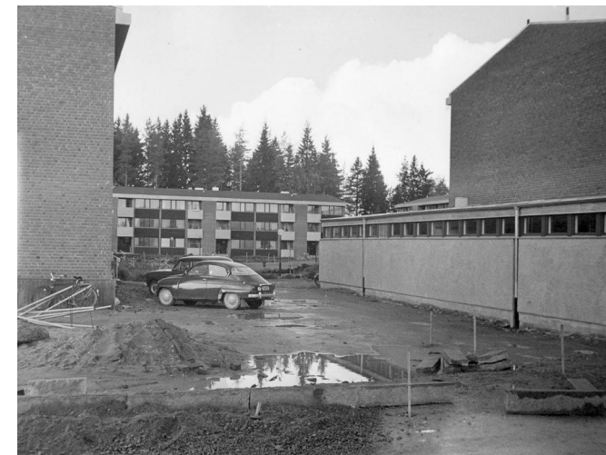
Varberga under uppförandet. Intill gårdarna uppfördes tvättstugebyggnader med putsade fasader och fönster i förband. Källa: Digitalt museum.
