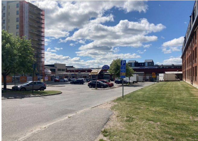
Centrum från norr med parkering i förgrunden. Om- och tillbyggnader ger ett oroligt uttryck. Till vänster i bild det i detaljplan skyddade bostadshuset.
