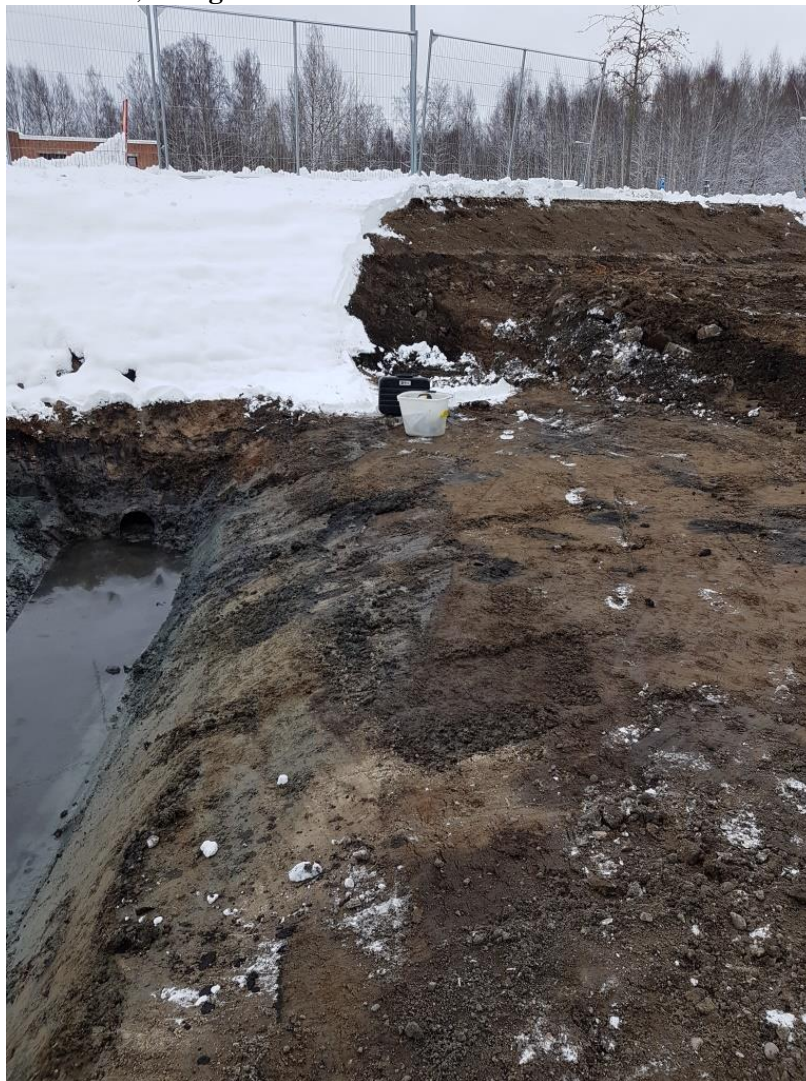
Figur 4.2. Framgrävd ledning med vatten inom enhetsruta C17 till vänster i bild.
