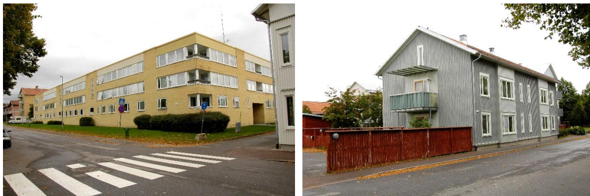
Till vänster en storskalig byggnad från 1969 på Bacchus 17. Till höger kvarteret Blomman där sentida bostadshus uppförts.
