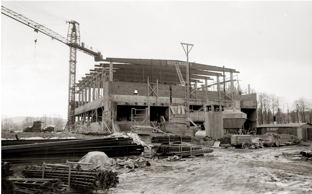
Idrottshuset under byggnation. (Foto från Fotocentralen i Nora.)
