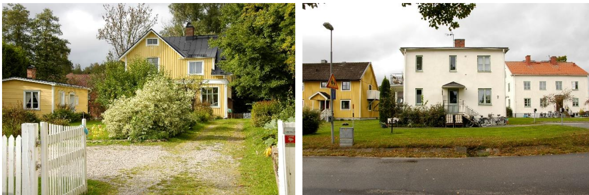
Till vänster: På Laxen 1 ligger ett sekelskifteshus. Till höger: På Laxen 16 finns två vita hus från 1930-talet där det ena är ett typiskt 1930-tals funkishus.
