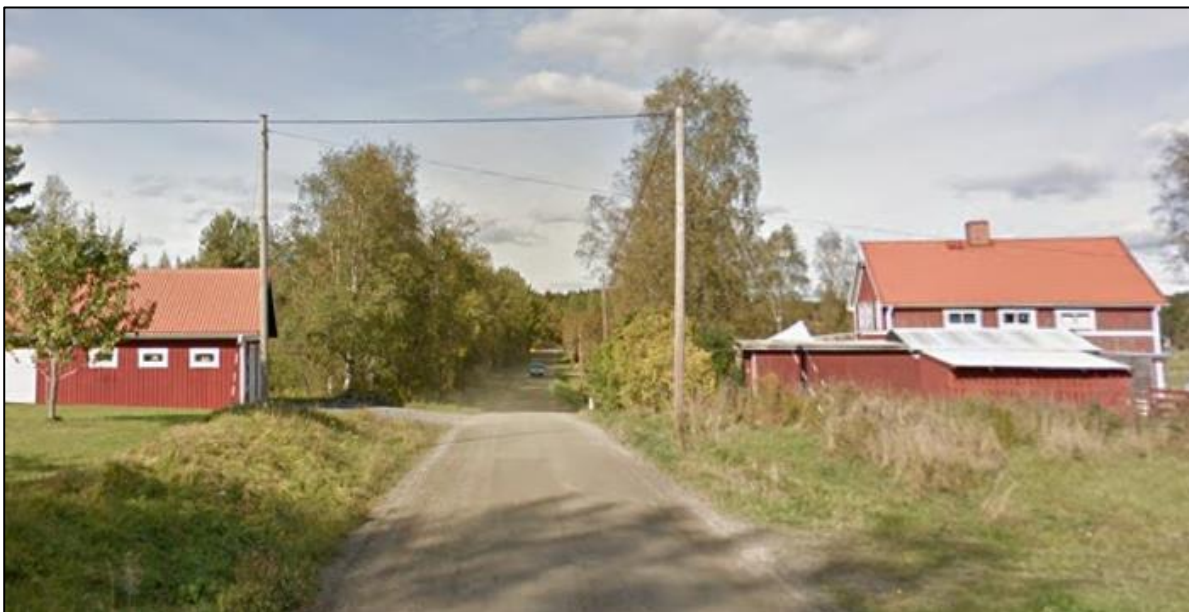
Figur 20. Byggnad ca 15 meter (till höger) från vägmitt. Foto: Google maps.
