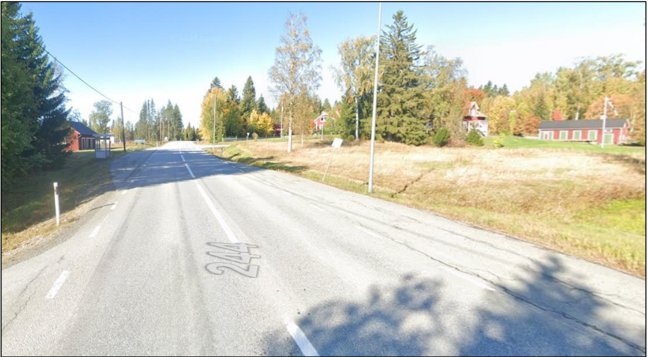
Figur 37. Hållplats Fogdhyttan västra hållplatslägen längs väg 244. Foto: Google maps.
