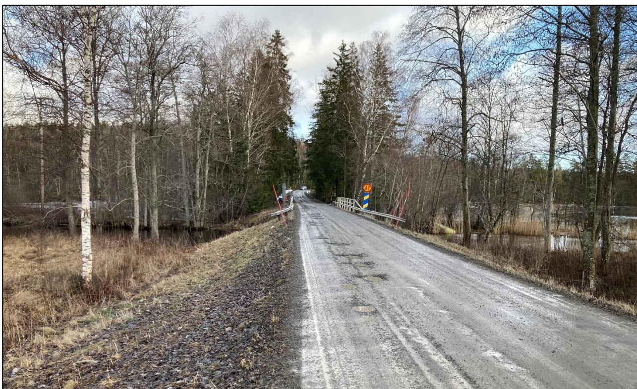
Figur 24. Bro längs väg 742. Foto: WSP, 2025.
