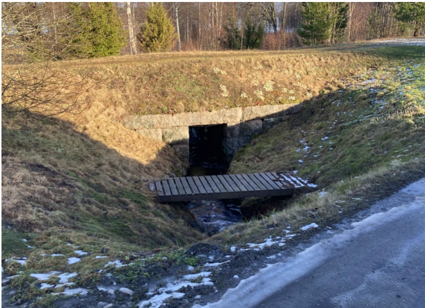
Figur 24. Viadukten under tidigare järnvägen
