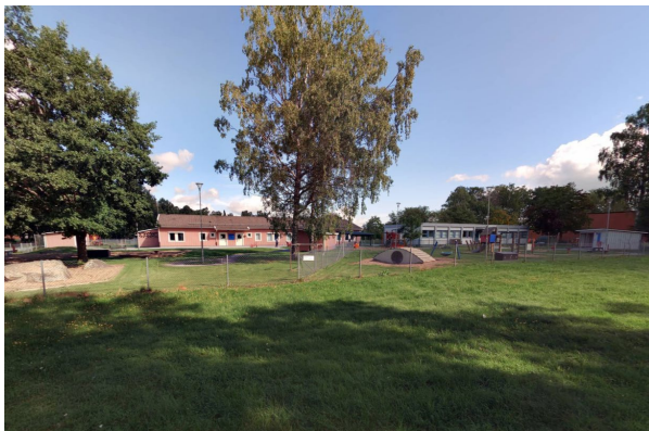
Foto av byggnader i Vivallaparken som tidigare fungerat som förskolor. Byggnaderna anses avlägsnas innan detaljplanens genomförande. Längst till höger i bild skymtar även idrottsanläggningen Öknahallen som anses bevaras.
