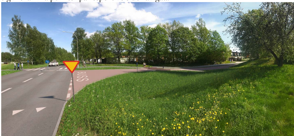
Bild över hur anslutningen till Vivallaringen kan komma att anordnas. Förslaget bygger på att den befintliga gång- och cykeltunneln fylls igen och att alla trafikslag passerar Vivallaringen i plan. (Bild från WSP)
