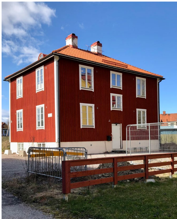
Byggnaden inom Öresjön 8 med symmetriska fasader, tidstypisk fönsterutformning, flackt valmat tak med röda takpannor och en rundad takkupa med lunettfönster.
