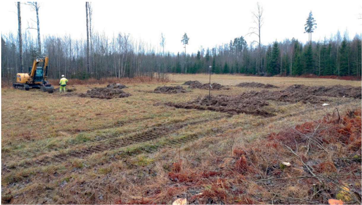
Figur 5. Sökschaktning inom den sydöstra delen av objekt 17. Foto från norr.
