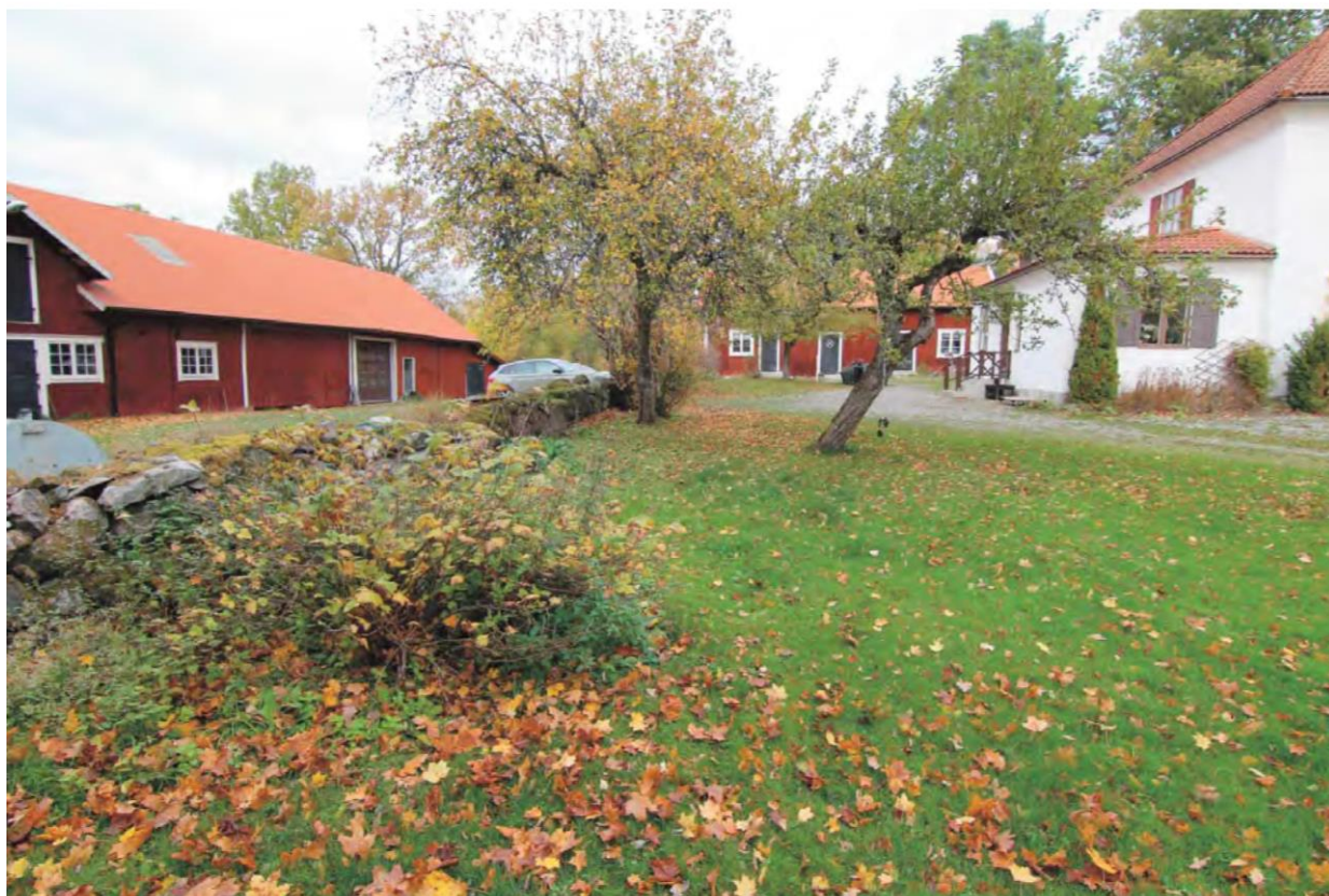
Figur 17. Björneborgs gårdscentra sett från söder. Till höger syns bostadshuset och i bakgrunden drängstugan. Till vänster syns den kallmurade stenmuren som delar bostadsområdet från ekonomibebyggelsen. Vänster i bild syns även ladugården. Källa: Fredriksson arkitektkontor ab, 2022.
