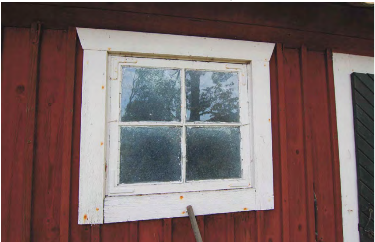
Utformning av fönster med enkelglas. Fönstren har hörnjärn och dekorativt vinklade överstycken.
