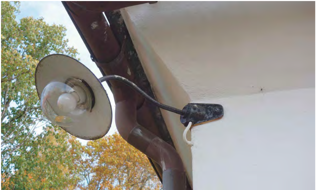
Lamphus av stål, porslin, glas och emaljerad plåt i byggnadens nordvästra hörn. Armaturen är från tidigt 1900-tal. Här syns även den kraftigt snedfasade takfoten.
