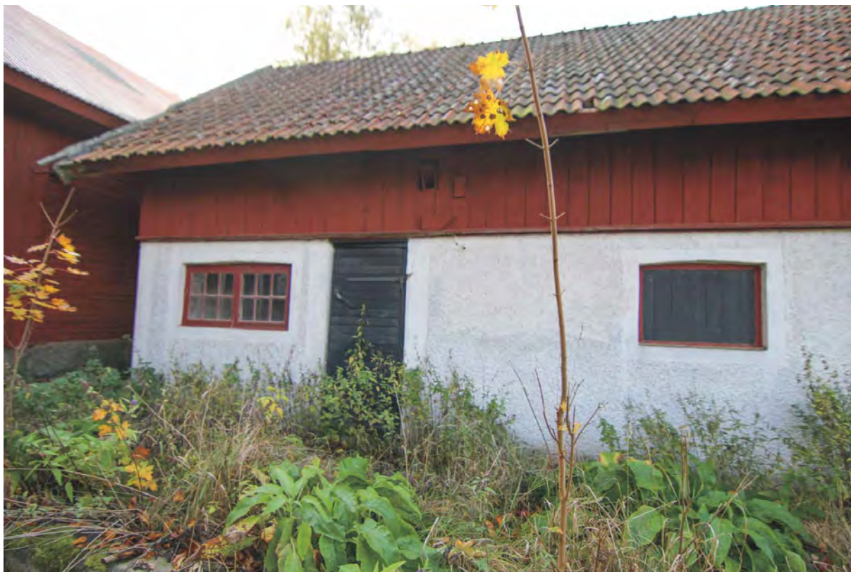
Fasaad mot norr. Mellan dörr och luckan till böger finns ett bomparti i putsen, men denna sitter ändå fast på väggen. Notera öppningarnas svaga välvning.
