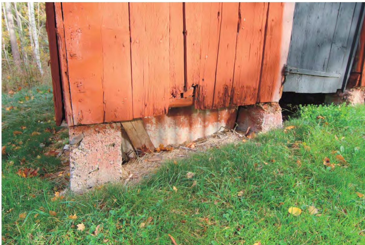
Plintgrund och panelbeklädnad.
