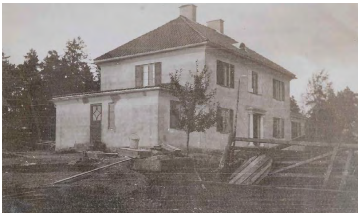
Bostadshuset under pågående ombyggnation. Man kan se byggnadsmaterial liggande framför byggnaden. Huset fick en markant modern prägel för tiden. (Örebro länsmuseum)
