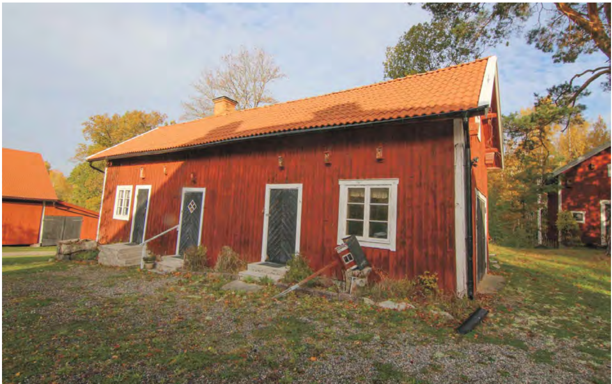
Fasaden från sydöst med sina tre entréer och fönster.
