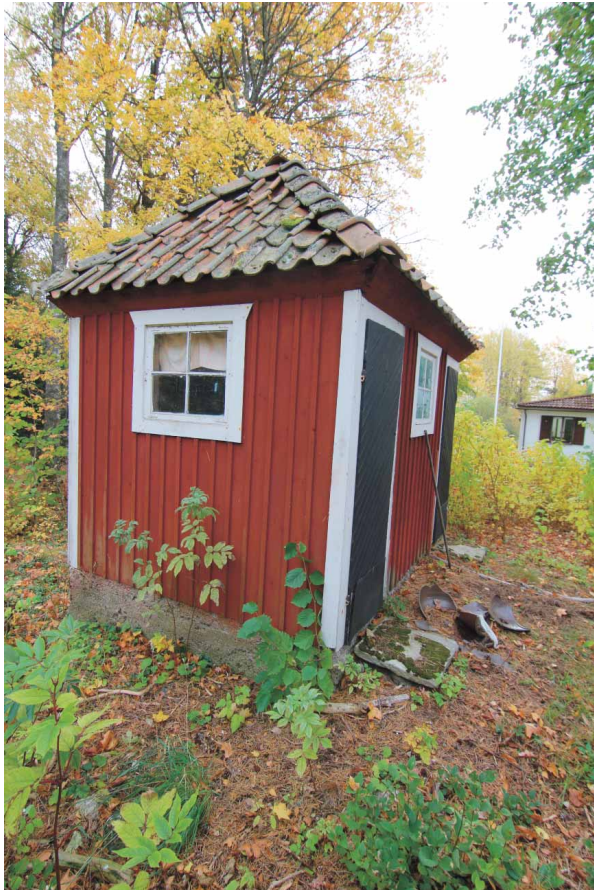
Fasad mot norr.
