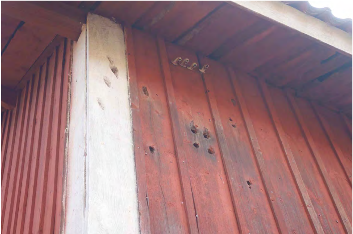
Panelen mot väst, äldre håltagning för tekniska installationer. Porslinsisolatorer i genomföring sitter kvar i väggen.
