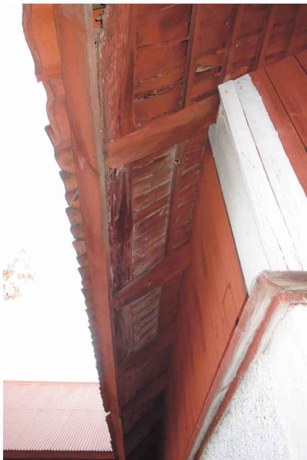
Byggnadens takkonstruktion, bögben bearbetade med yxa. Underlagstak av hylade spån.
