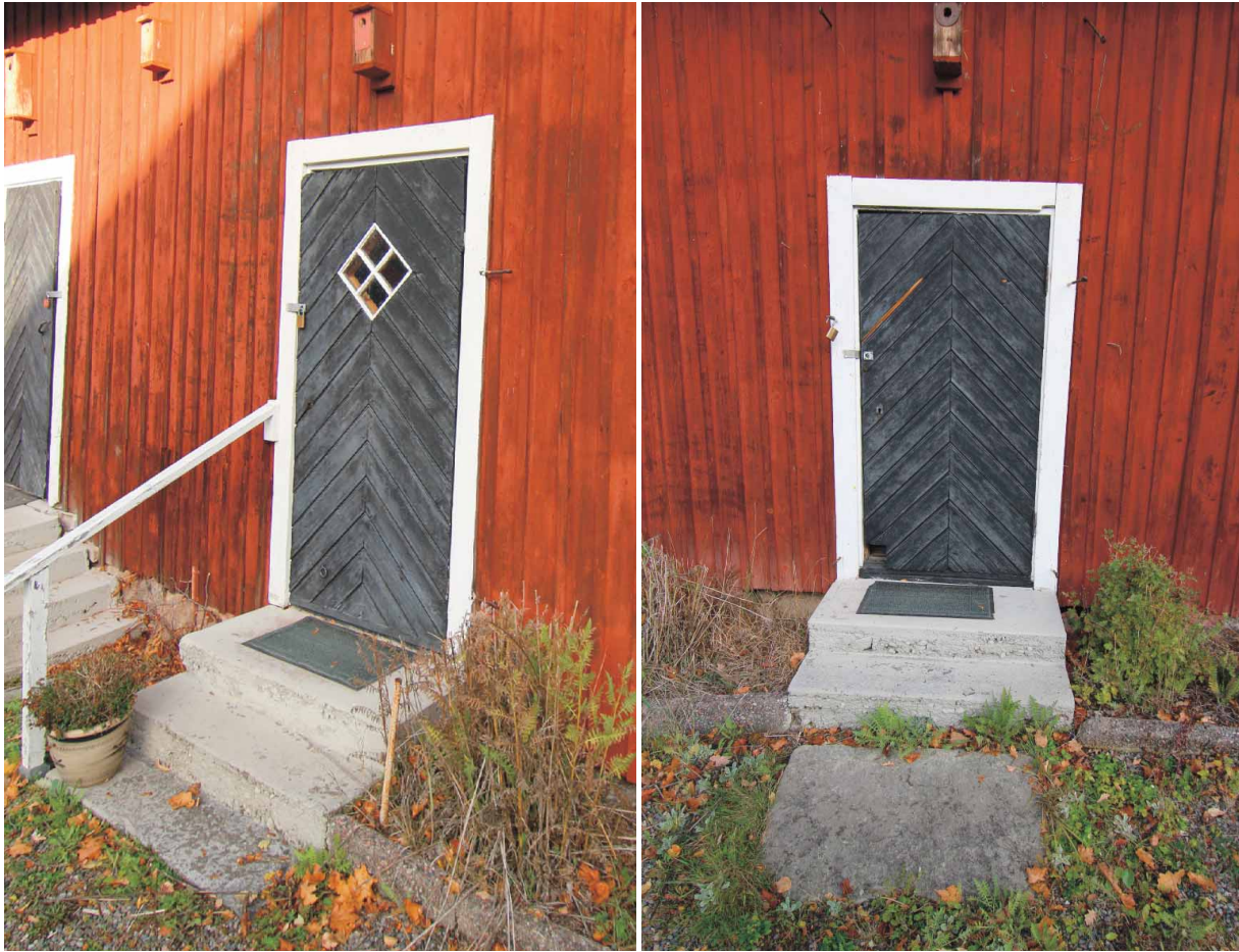
Entrédörrar från tidigt 1900-tal samt betongtrappor.
