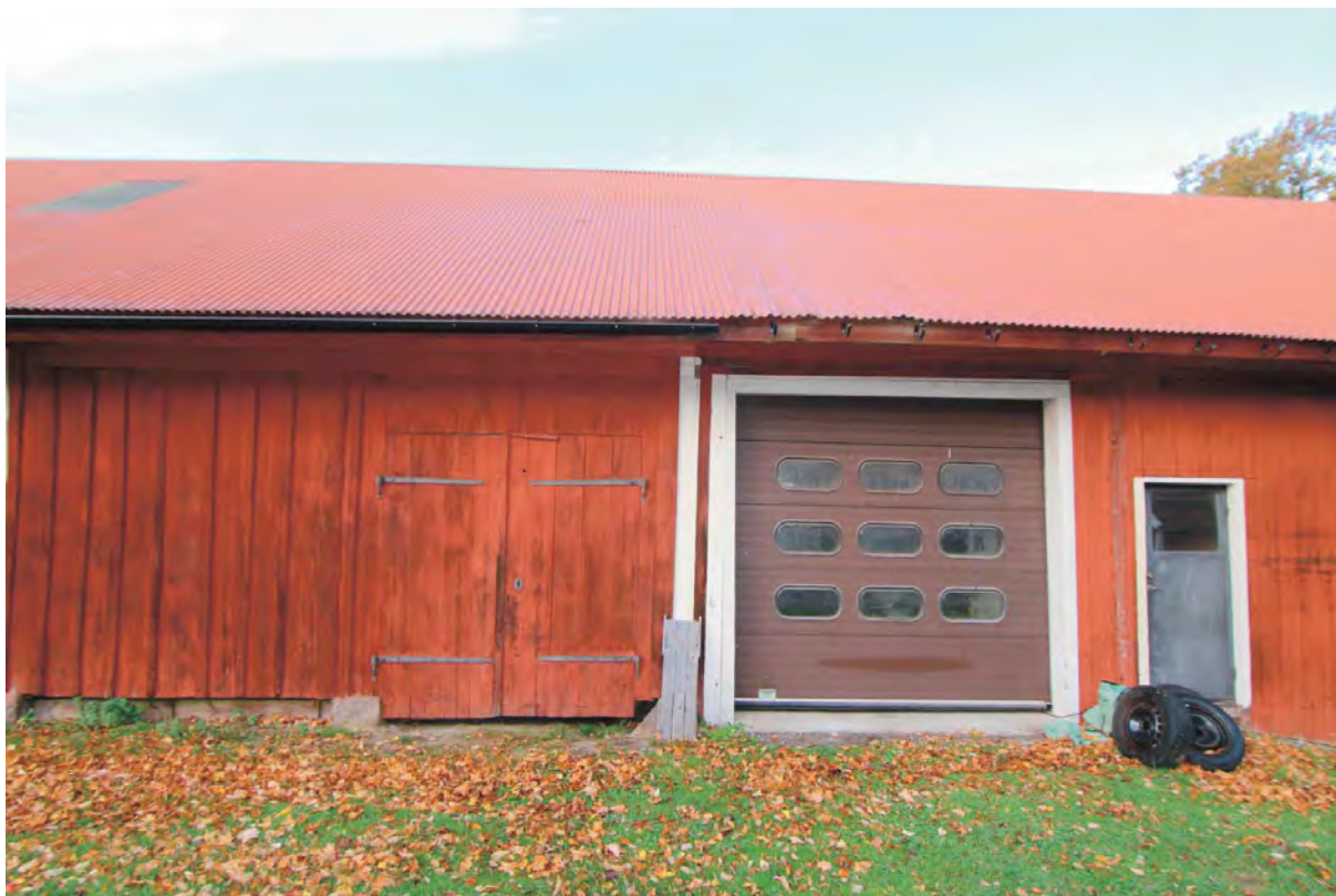
Rödfärgad port bredvid den senare installerade garageporten.
