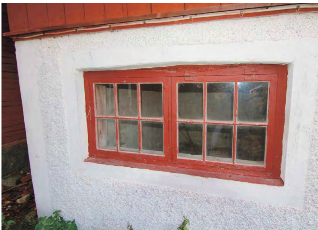
Fönster mot norr.
