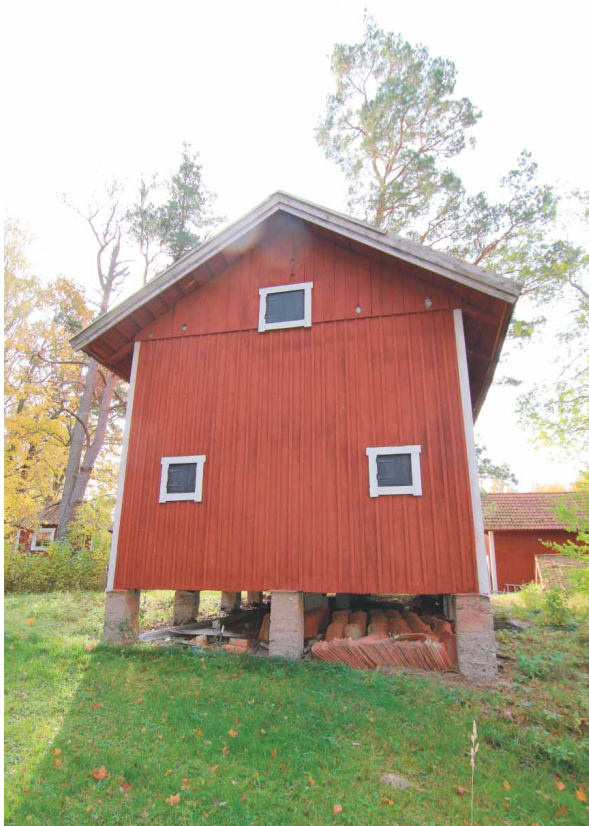
Norra gavelfasaden med luckor och fyra backspettshål i gavelpartiet.
