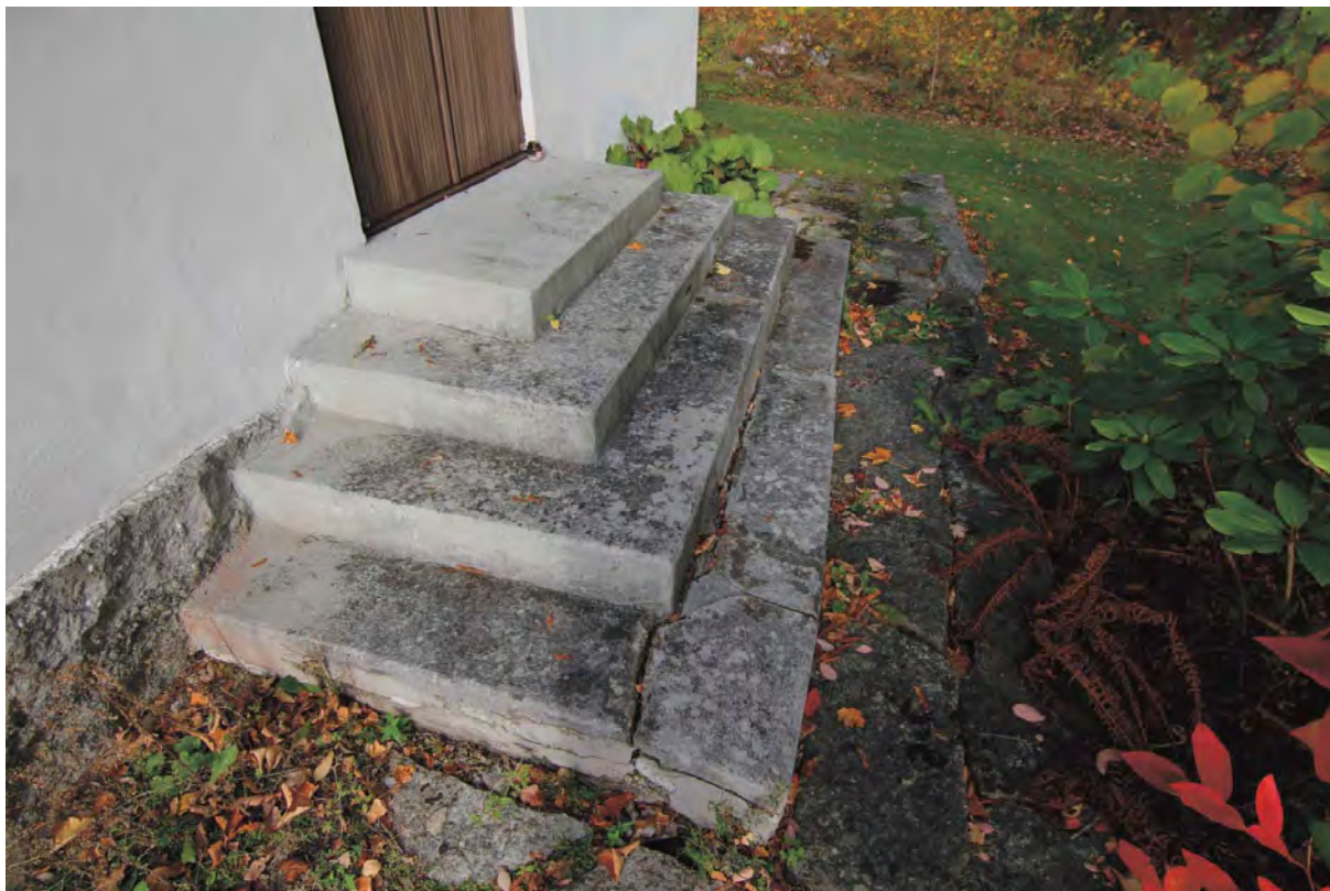
Gjuten trappa vid byggnadens östra sidoflygel.
