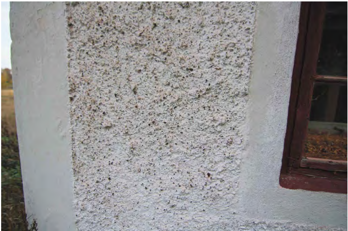
Spritputsfasad med slätputsad omfattning runt fönster och vid börn.
