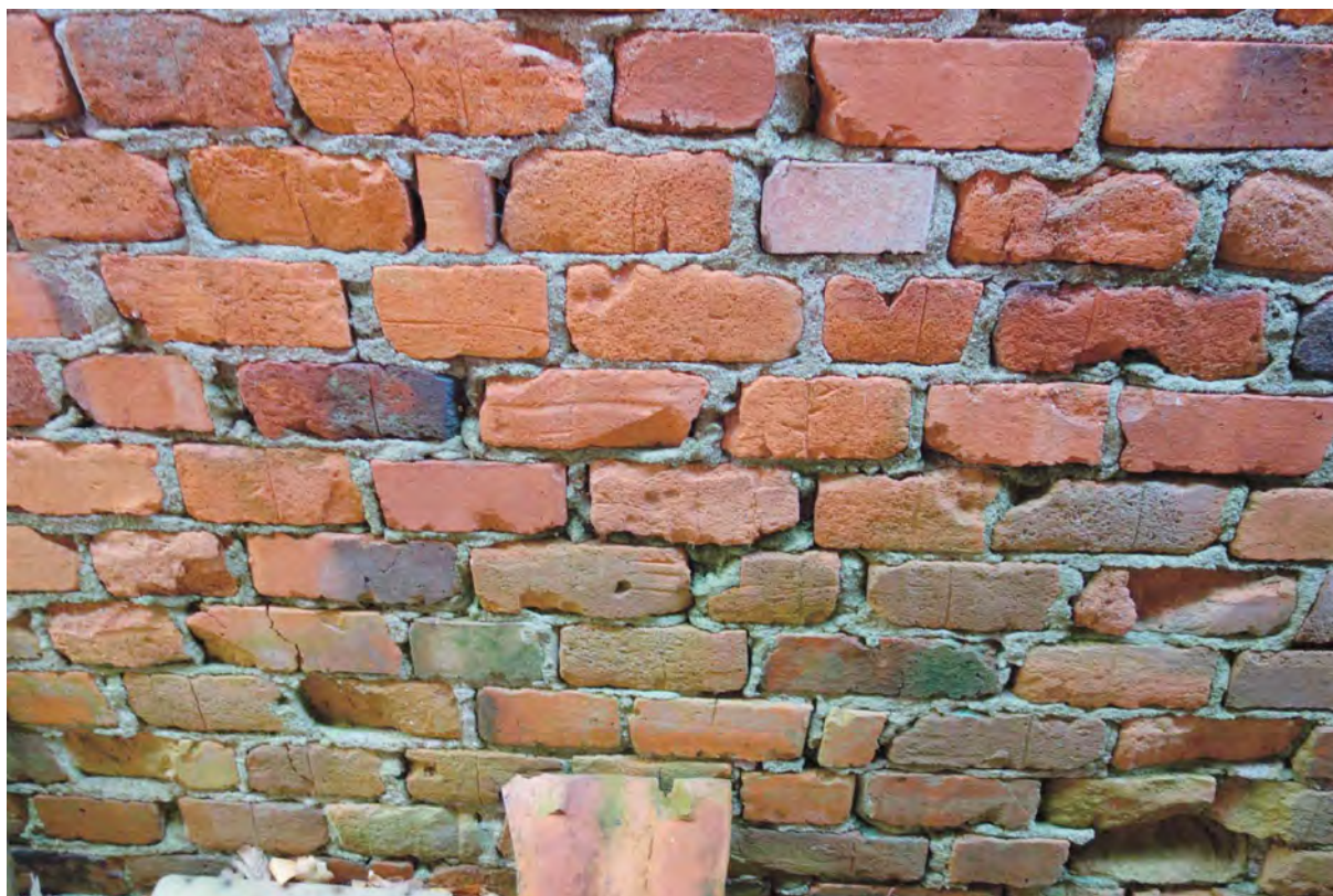
Murad tegelvägg med flertalet spår från hantering av tegel innan bränningen i form av fingeravtryck.
