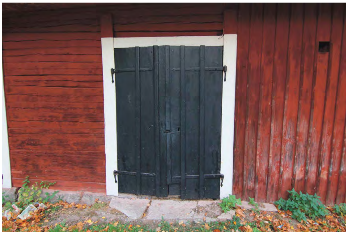
Entrédörr av hög ålder, av allt att döma äldre än tiden då ladugården uppfördes.
