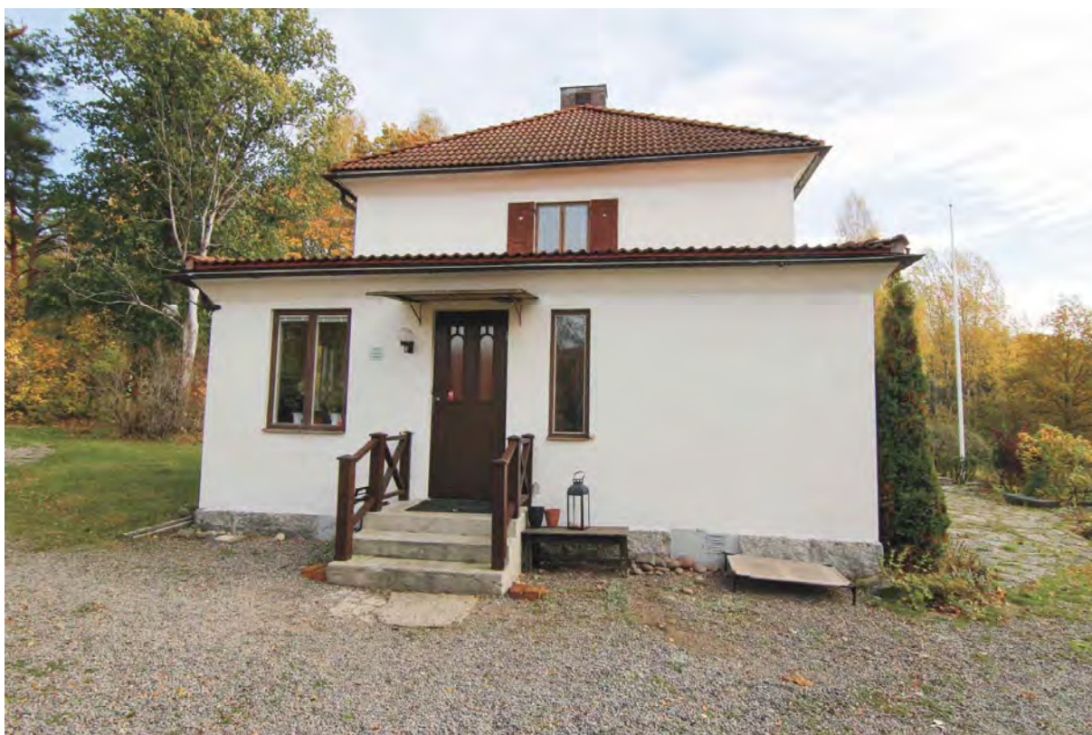
Västra sidoflygeln med entrédörr. Dörren är bytt under 2000-talet. Notera den breda vinklade takfoten.
