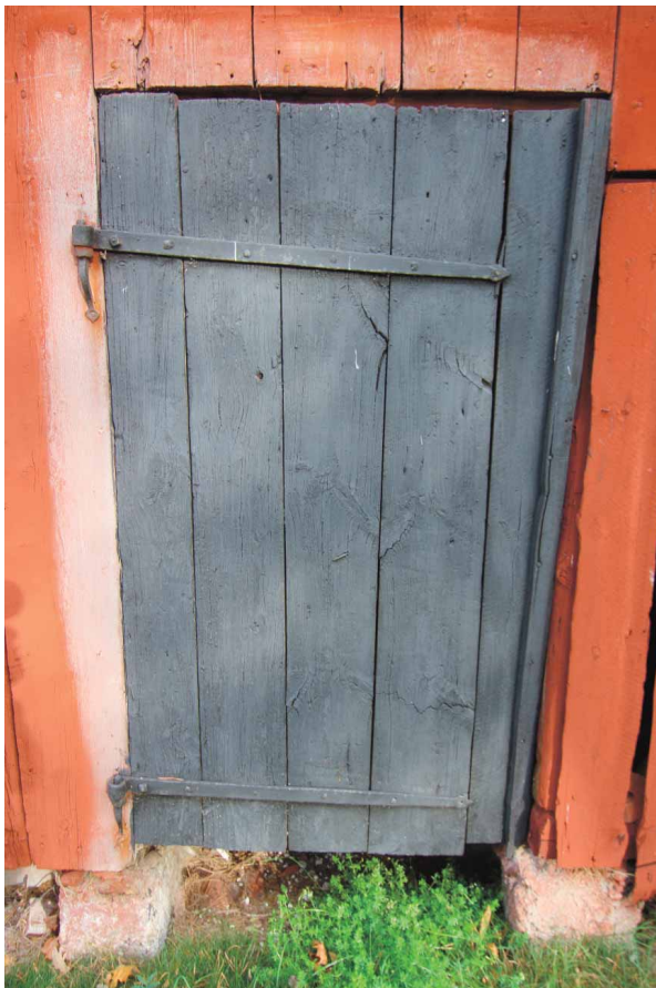
Entrédörren av betydande ålder med smidda gångjärn och fyrkantsmutter.
