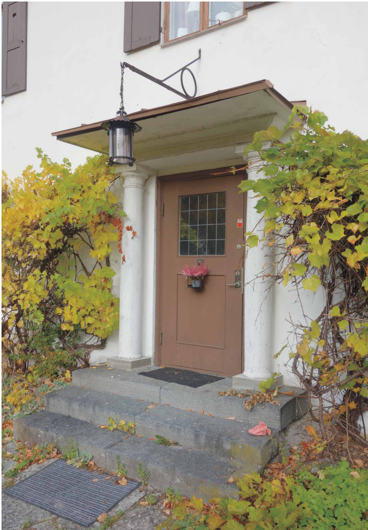
Södra entrén med trappa, kolonner, överstycke, tak och lykta. Kolonnerna och dörröverstycket är ursprungliga. Dörr, tak och armatur är tillkomna under 1900-talets mitt.
