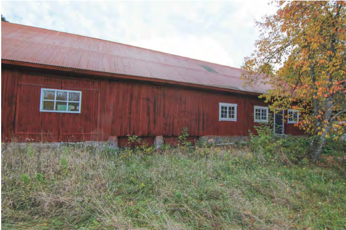
Ladugårdens västra fasad. Stengrunden är upphöjd och har plintar vilket tyder på att man troligen haft en öppning här som nu är igensatt.
