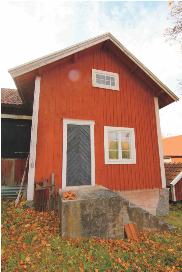
Norra gavelsidan med entré och betongtrappa.
