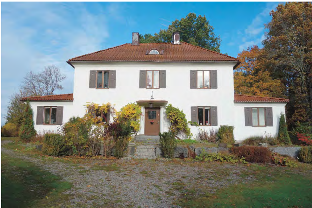
Bostadsbuset sett från söder. Här syns den generella utformningen i två plan, sidoflyglar, högt valmat tak och symmetrisk fönstersättning med fönsterluckor.
