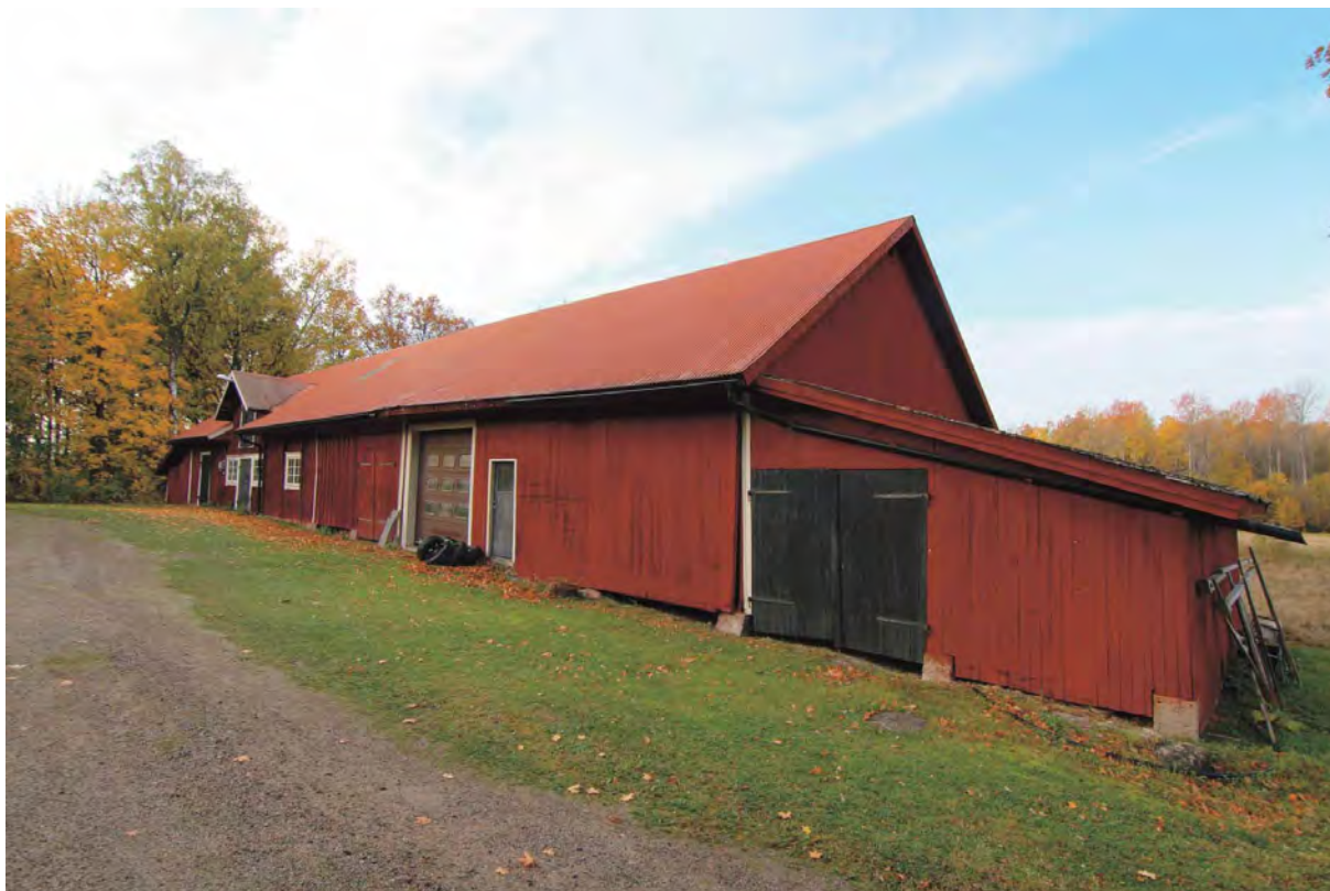
Ladugården sedd från nordöst. Tillbyggnaden till höger har betongplint i grunden medan övrig ladugård har stengrund. Här syns även plåttaket och den senare installerade garageporten.
