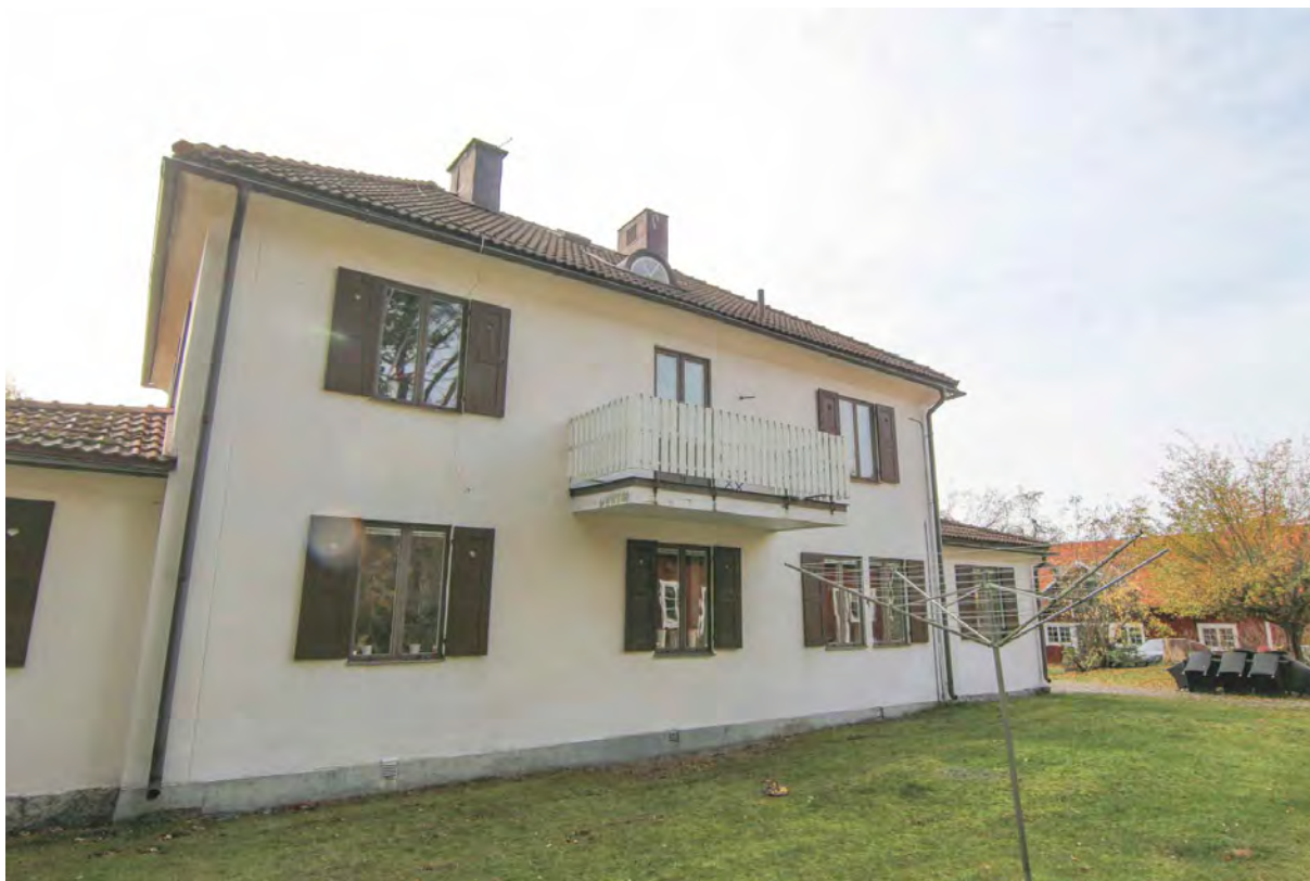
Byggnadens norra fasad med balkong.
