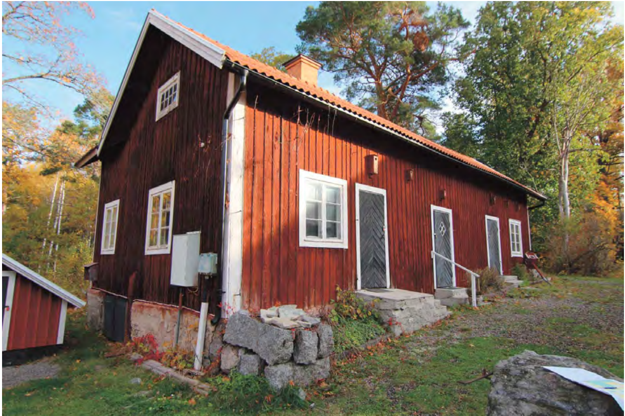
Drängstugan sedd från sydväst.
