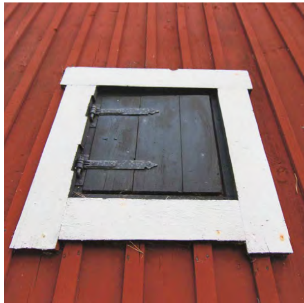
Magasinets lucka för torkning av magasinerat spannmål eller dyl.
