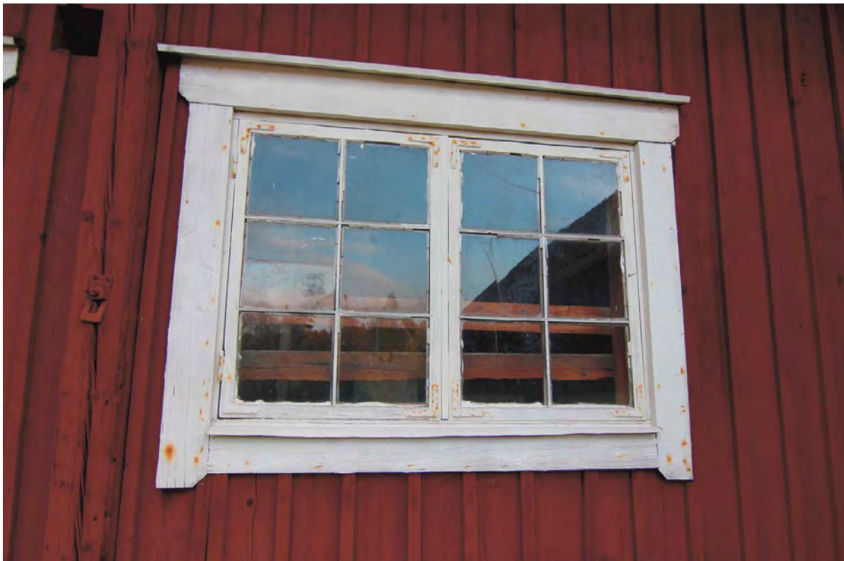
Typutformning av ladugårdens fönster. okopplade fönster med hörnjärn.
