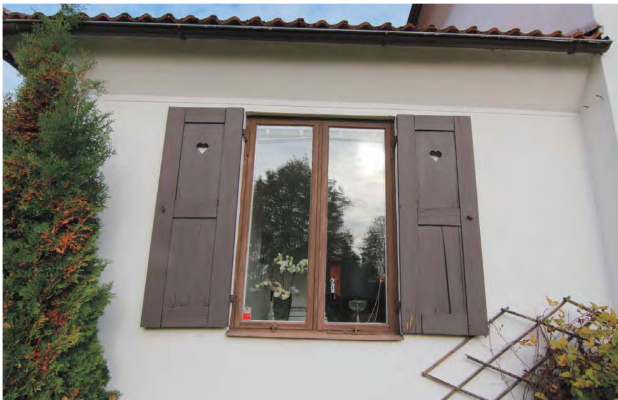
Generell fönsterform, tvåluftsfönster utan spröjs, av allt att döma bytta på 1970-tal. Fönsterluckorna är från 1920-talet och bevarade i hela byggnadskroppen. Fönsterluckor och fönsterbågar har inte samma kulör.
