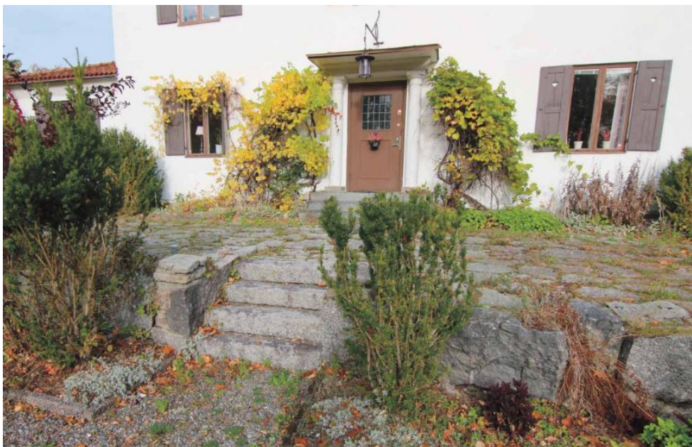
Terrassen med beläggning av kalksten och granitstenar som kant för nivåskillnaden. Foto: Fredriksson arkitektkontor AB
