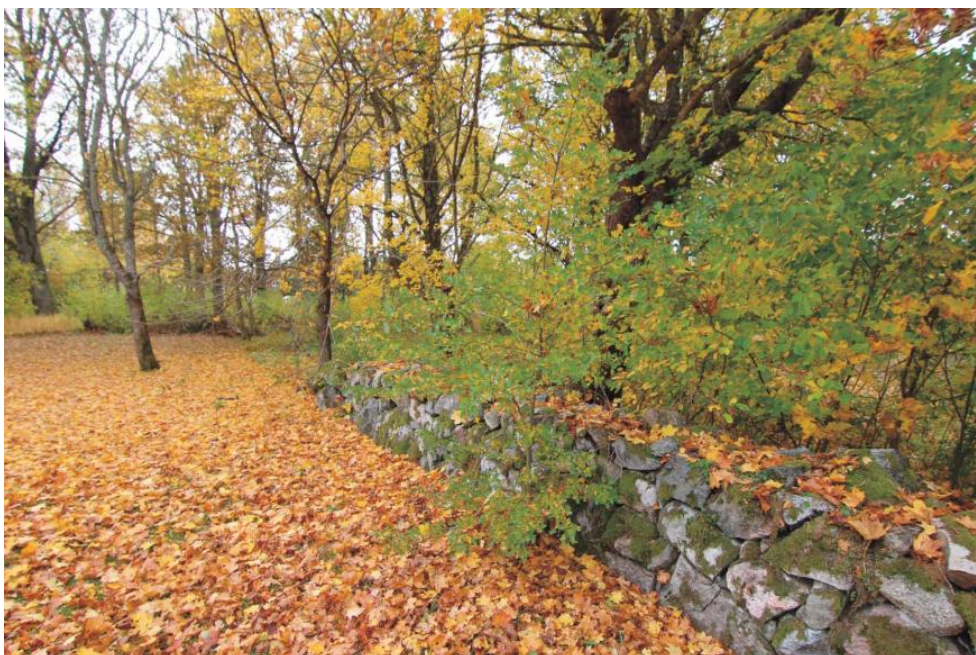
Del av den kallmurade stenvallen som delar gårdens bostads/parkområde från ekonomibyggnaderna. Foto: Fredriksson arkitektkontor AB
