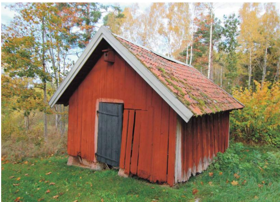
Förråd. Foto: Fredriksson arkitektkontor AB
