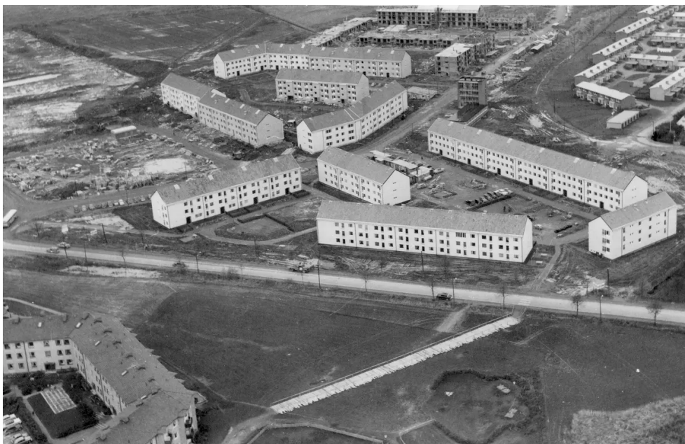
Flygbild över byggnation av Tybble bostadsområde, 1958 (Bild: Örebro Stadsarkiv)
