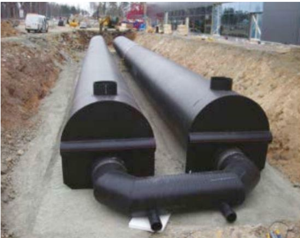
Figur 25. Exempel på underjordiskt rörmagasin (Foto: Uponor).
