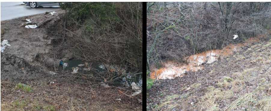
Figur 29. Bild E: Trumma under infartsväg till Gasum till vänster. Dike mellan Tippvägen och Gasum till höger.
