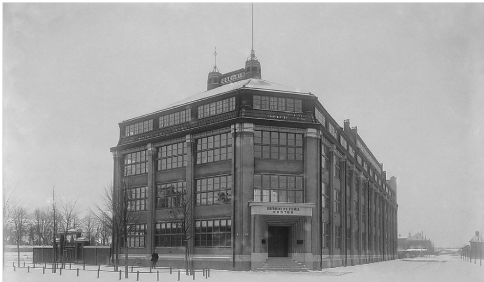
Bild som visar fabriksbyggnadens första etapp.
