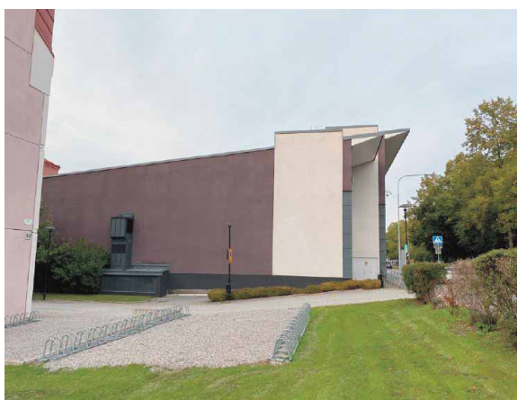
I anslutning till 1988 års byggnads östra gavel och södra gårdsfasad finns en häckomgärdad gräsyta. Närmast östra gaveln finns en grusad cykelparkering.
