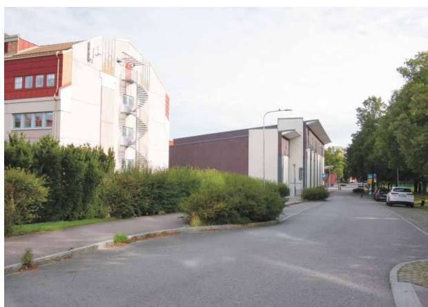
Häckomgärdad gräsyta från sydöst.
