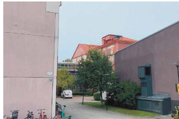
6. Siktlinje mellan gata/park och fabriksbyggnadens södra gavel.
