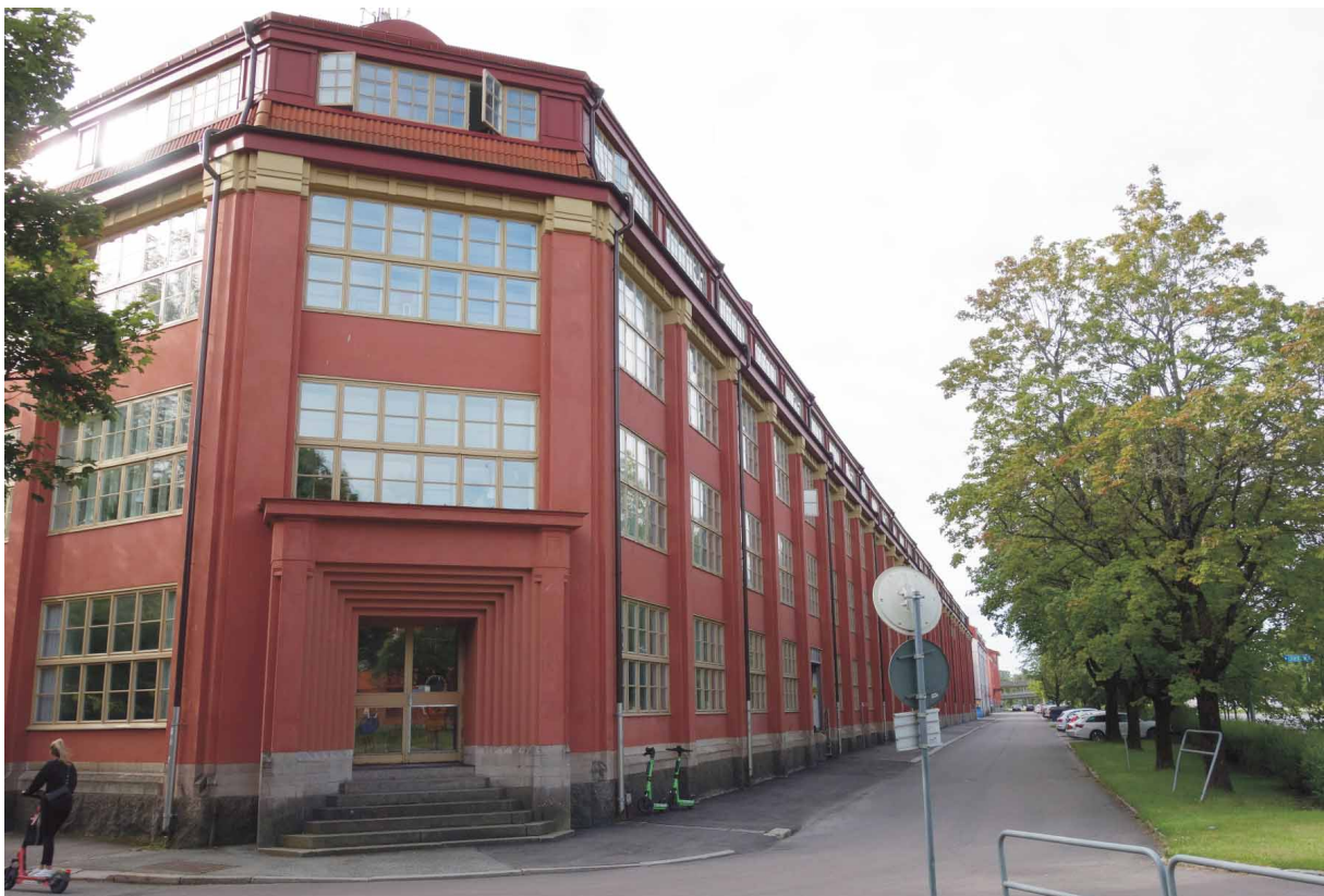
Nuläge, Oscariafabrikens monumentala entré i nordväst samt den långsträckt västfasaden.
