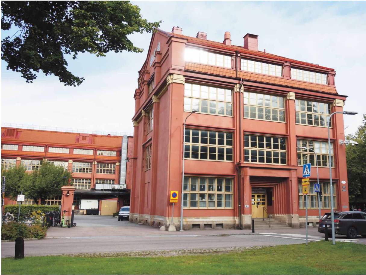
Nuläge, Oscariafabrikens östra gavel samt del av östra gårdsfasaden.
