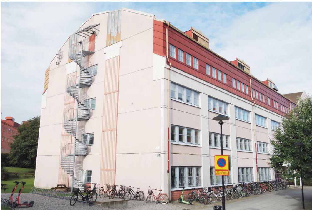
Nuläge, 1988 års byggnad. Fasad mot norr samt gavel mot öster.
