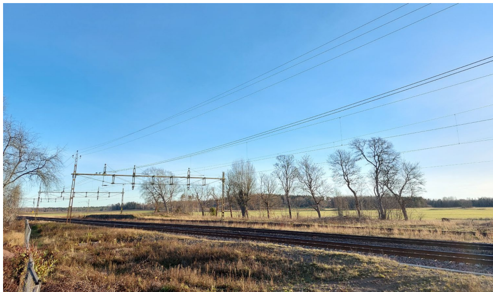
Figur 10. Befintlig järnvägssträckning vid slättlandskapet vid Ölme.
