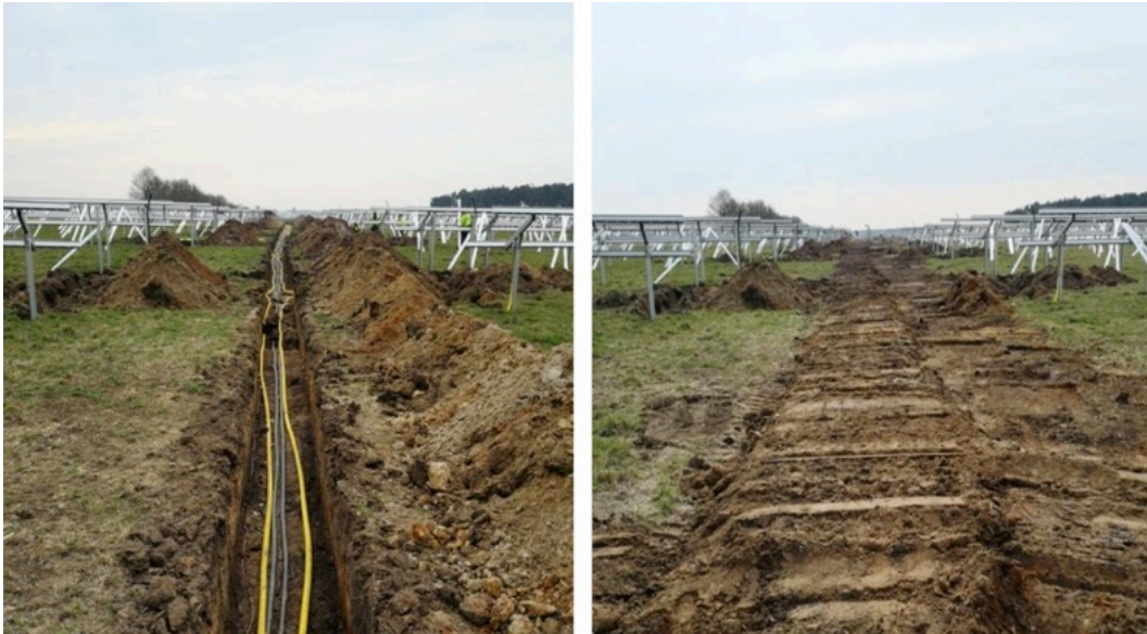
Figur 3.7: Schakt för kabelgångar (©Svea Solar).
