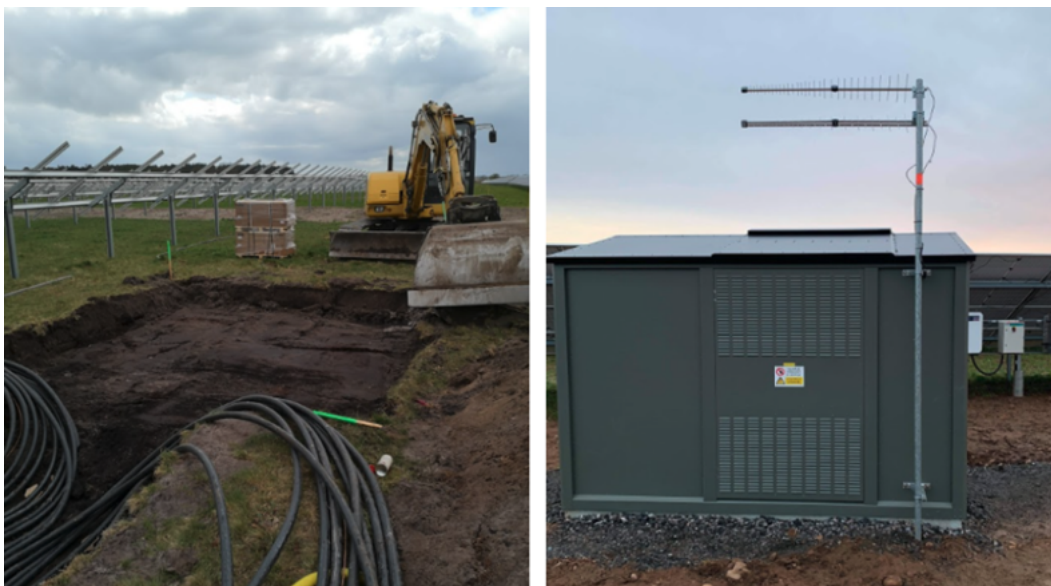
Figur 3.4: Vänster: markförberedelser för transformatorstation. Höger: transformatorstation. (©Svea Solar)
