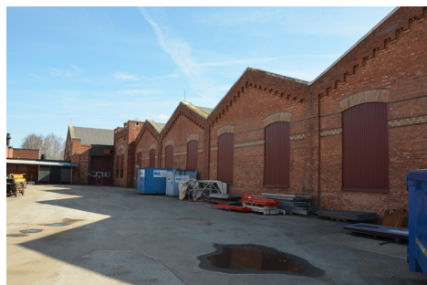
Norra fasaden. Foto 2017.
