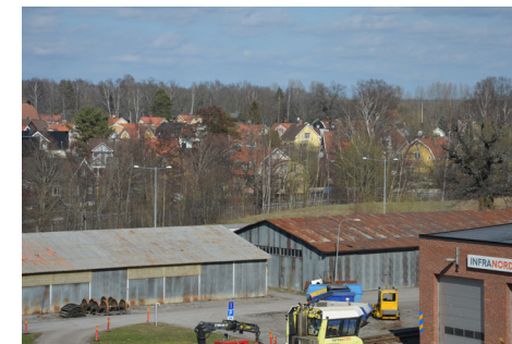
Enkla förråd med fasader av korrugerad plåt byggda 1952 respektive 1955. Norr om motorvagnsverkstaden. Foto 2017.
