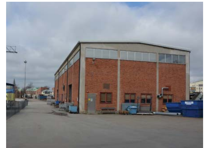
Vy östra fasaden. Foto 2017
