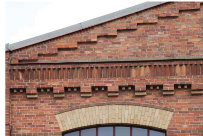
Detalj fasad med mönstermurning. Foto 2017
