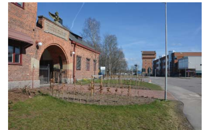
Södra fasaden, vy mot vattentornet i öster. Foto 2017
