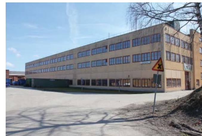
Norra fasaden. Foto 2017
