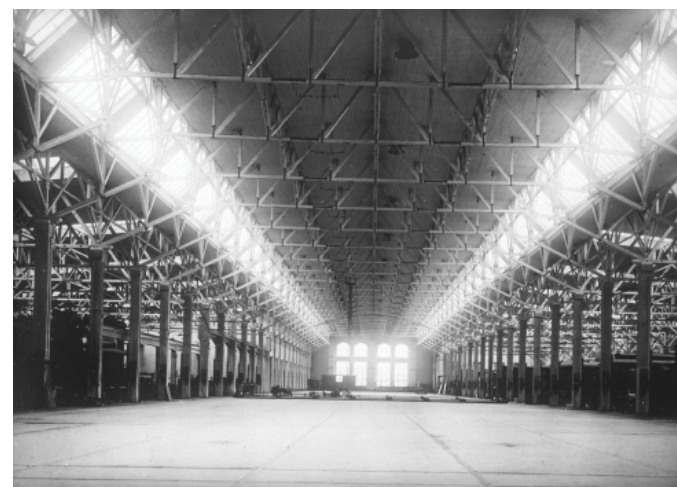
Interiör från vagnverkstadens centrala skepp med dagsljus från stora fönsteröppningar och taklanterniner innan de sattes igen av enerigbesparingsskäl i slutet av 1900-talet. Foto 1909. Källa Örebro stadsarkiv
