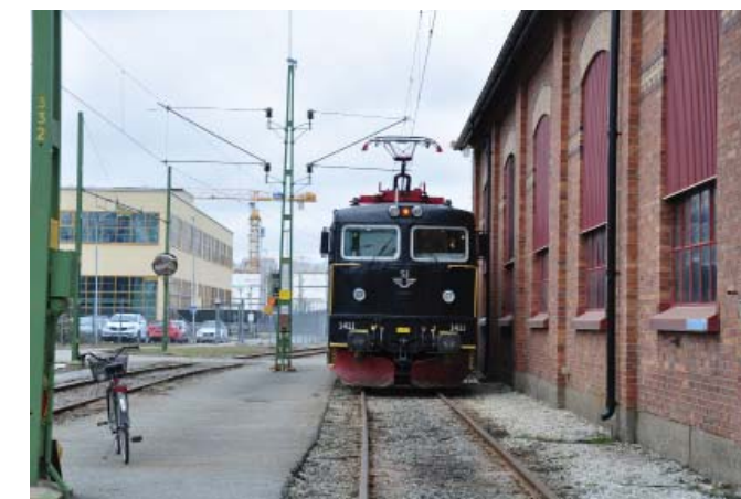
Del av östra och norra fasaden, till höger i bild syns komponentförrådet. Foto: 2017
