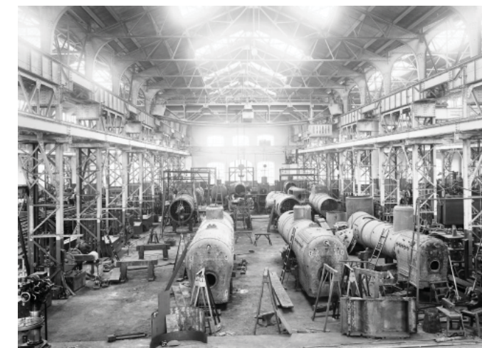
Interiör plåtslagarverkstaden mellersta skeppet. Foto 1910-tal. Källa: Örebro stadsarkiv
