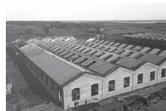
Vagnverkstaden under uppförande, Foto 1907. Källa: Örebro läns museum.
