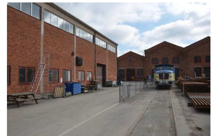
Södra fasaden. Möte mellan motorprovhallen och plåtslagareverkstadens resliga gavelparti. Foto 2017
