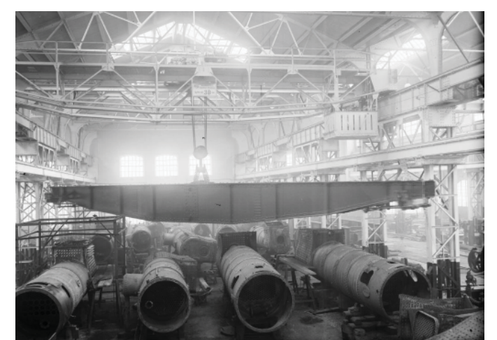
Vändskiva transporteras med travers i plåtslagareverkstaden. Foto 1912. Källa: Örebro stadsarkiv
