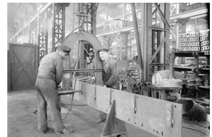
Nitning av bottenplåt. Foto 1920-tal. Källa: Örebro stadsarkiv
