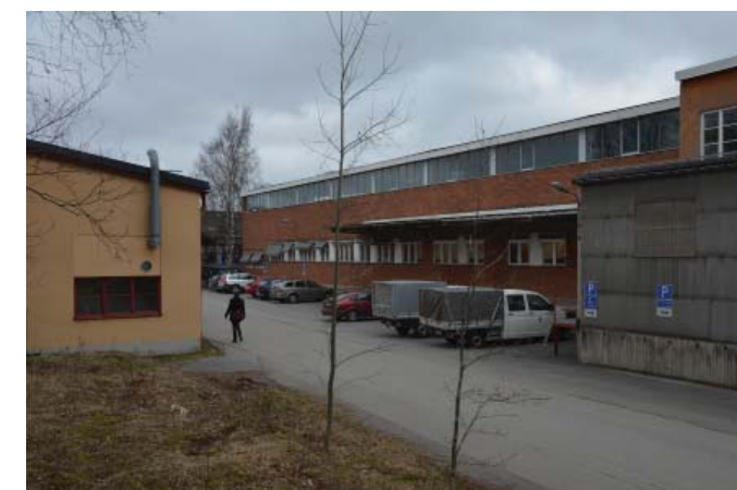
Tillbyggnaden från 1950-talet. Foto 2017
