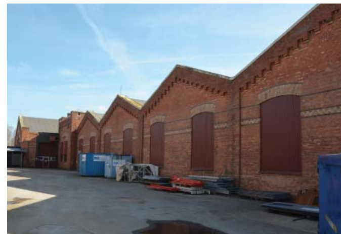
Norra fasaden. Foto 2017
