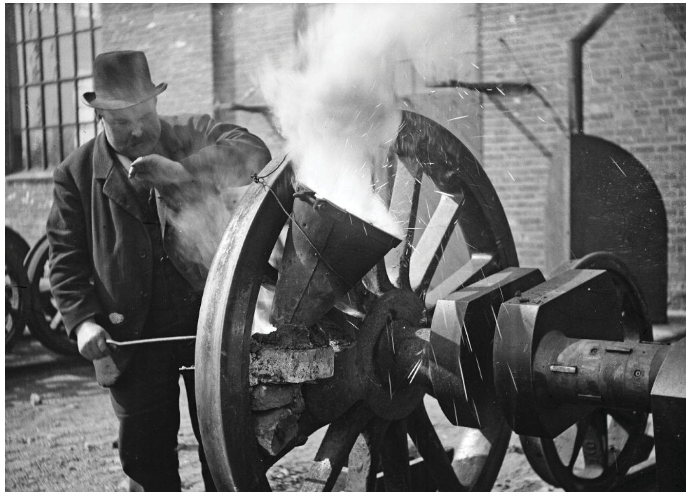
Reparation av hjul med ny gjutning. Foto 1910-tal. Källa: Örebro stadsarkiv
