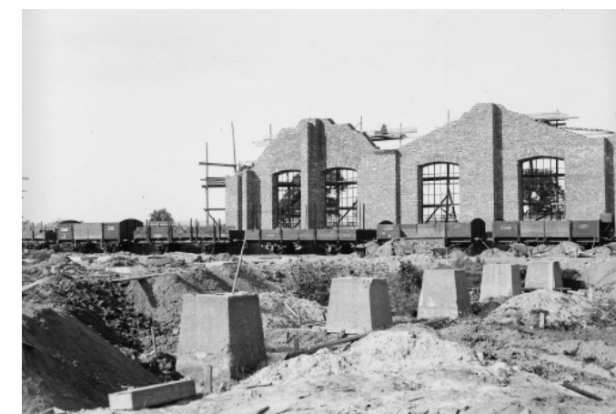
Vagnverkstaden under uppförande. Foto 1906. Källa: Örebro stadsarkiv
