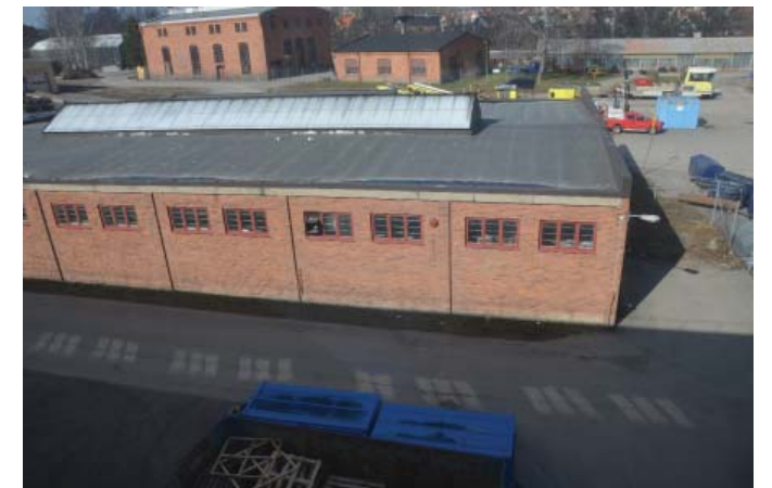
F.d. maskinsnickeri, södra fasaden. Foto 2017
