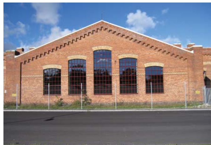
Södra fasadens mittskepp. Foto 2012
