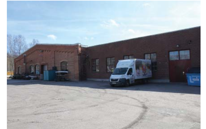
Norra fasaden. Foto 2017
