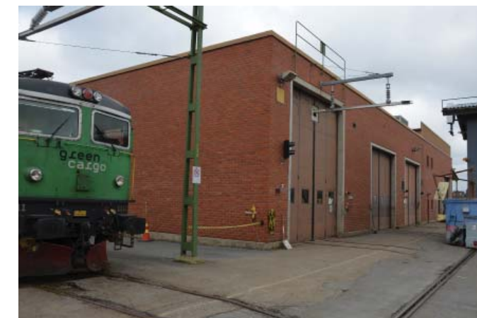
Vy östra fasaden. Foto 2017
