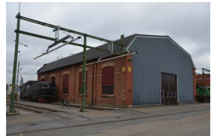
Byggnaden revs delvis på 1980-talet vilket resulterade i att den östra fasaden idag är av plåt. Foto 2017
