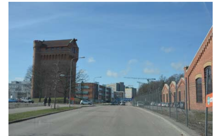
Vattentornet ingick tidigare i CV-området men är idag helt avskuren från verkstadsområdet. Foto 2017
