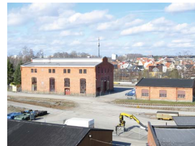
Vy värmecentralen och driftenheten. Foto 2017
