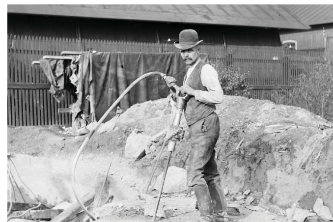
Arbetare med bergbormaskin. Notera trästaketet som omgärdade verkstadsbebyggelsen i bakgrunden. Källa: Örebro stadsarkiv
