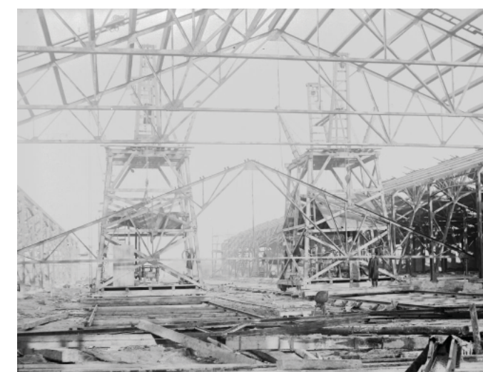
Vagnverkstaden under uppförande, Foto 1907. Källa: Örebro stadsarkiv
