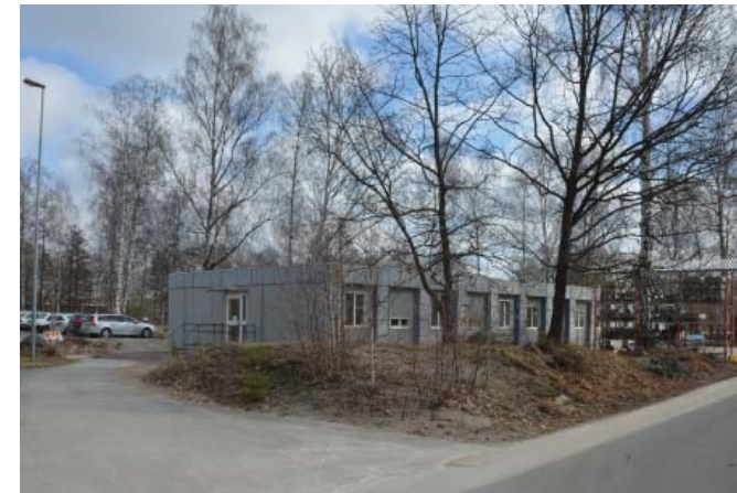
Kallförråd norr om plåtslagareverkstaden. Foto 2017
