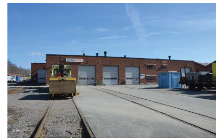
Västra fasaden. Foto 2017
