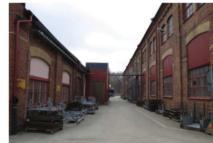
Södra fasaden, till höger elmekaniska verkstadens norra fasad. Foto 2017
