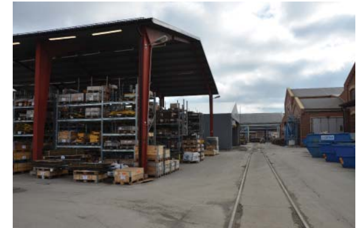
Skärmtak och plåtskjul norr om lokverstaden. Foto 2017
