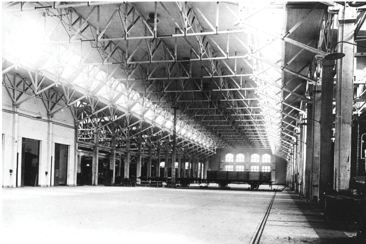
Interiör, vagnverkstaden med ursprungliga lanterniner. Foto 1909. Källa Örebro Stadsarkiv
