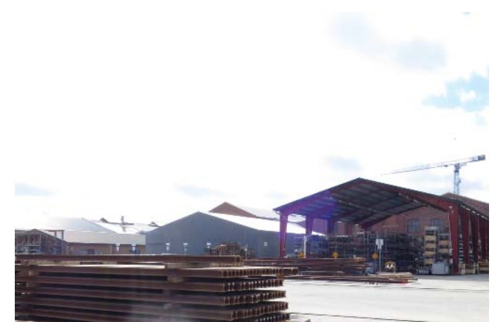
Längst till vänster i bild, förråd/skyddsrum. Foto 2017
