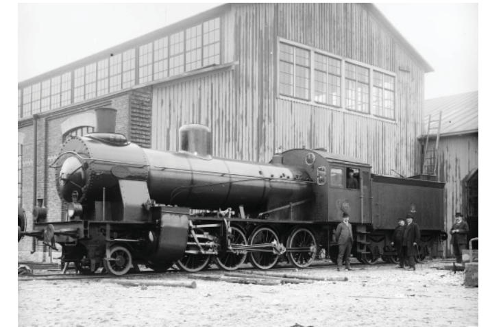
Det första reparerade lokomotivet utanför norra fasaden som då var i trä. Foto 1902
