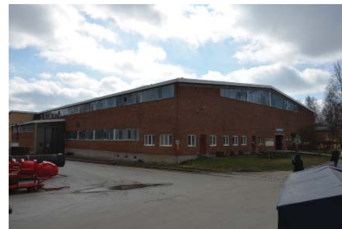
Tillbyggnaden från 1950-talet, västra och norra fasaden. Foto 2017
