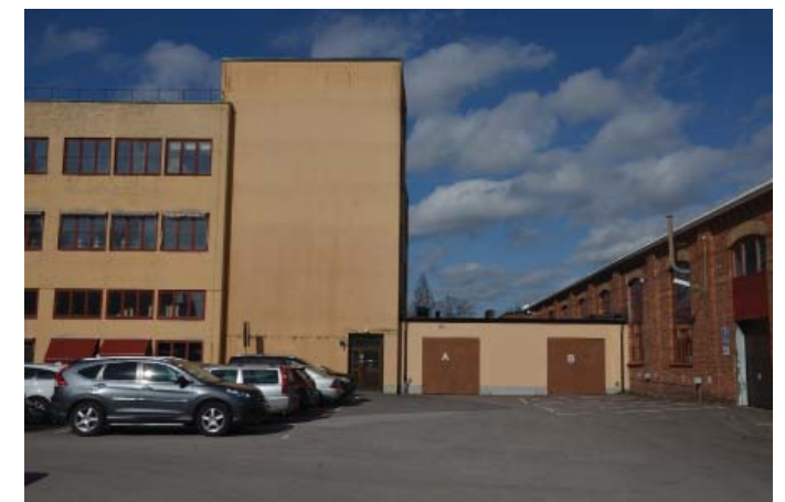
Mötet mellan vagnverkstaden och snickar-, polerar och tapetserarverkstad. Foto 2017
