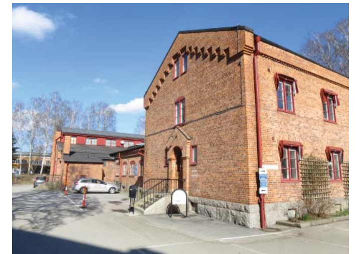
Västra fasaden. Foto 2017
