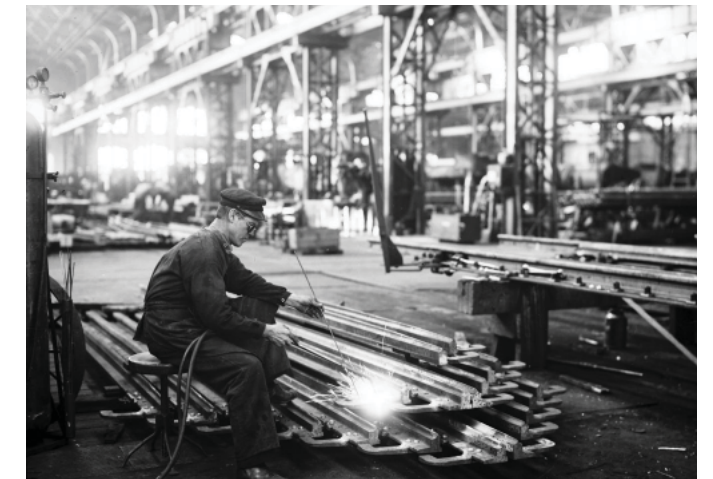
Interiör, svetsare i arbete i plåtslagareverkstaden. Foto 1910-tal. Källa Örebro stadsarkiv.
