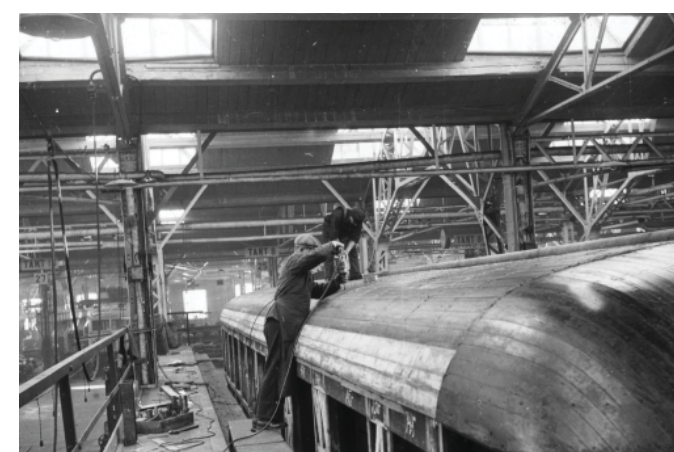
Reparation av vagnstak i vagnverkstaden. Foto 1909 Källa Örebro stadsarkiv
