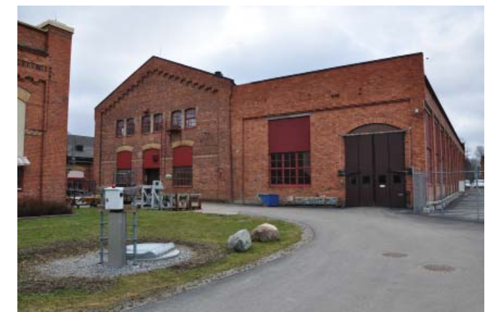
Västra fasaden. Foto 2017
