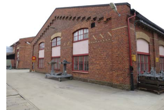
Västra fasaden. Foto 2017
