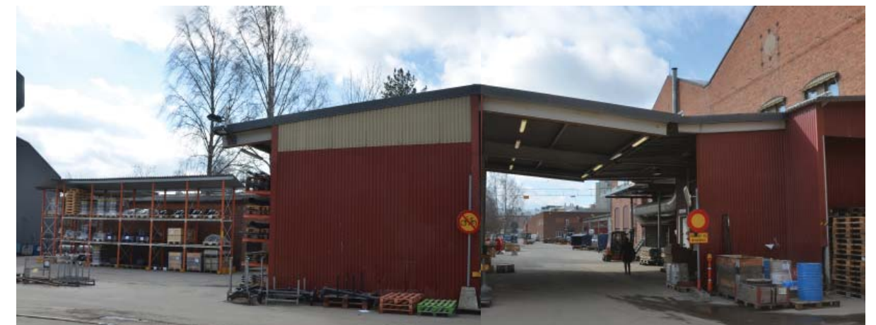
Skärmtak och upplag öster om plåtslagareverkstaden. Foto 2017
