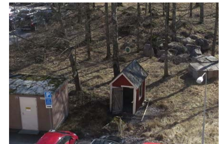
Liten träbyggnad där det ursprungligen fanns en våg. Foto 2017
