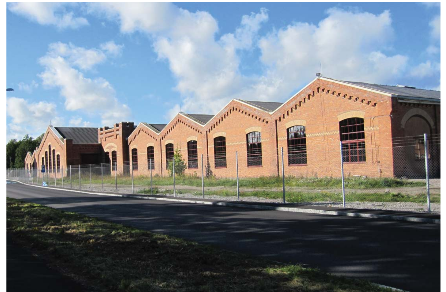
Vagnverkstadens södra fasad. Foto 2012
