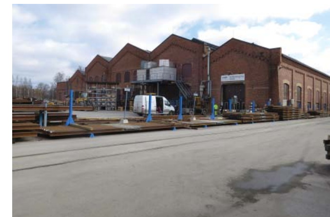
Västra fasadens resliga gavelparti. Foto 2017
