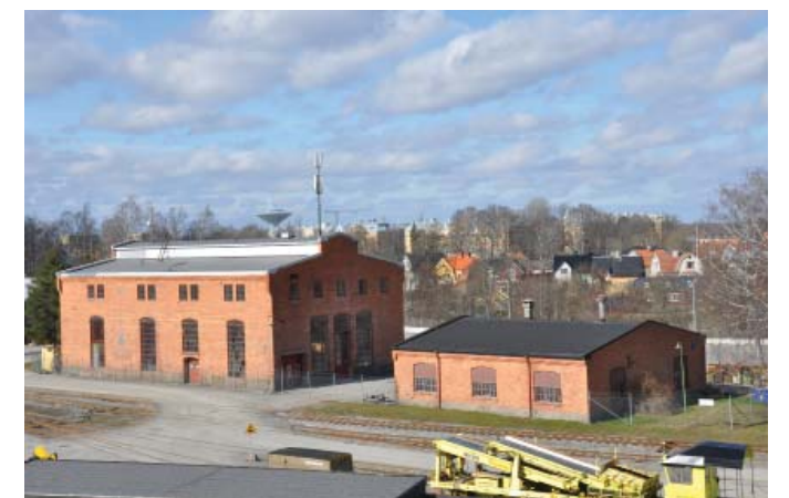
Vy värmecentralen och driftenheten. Foto 2017
