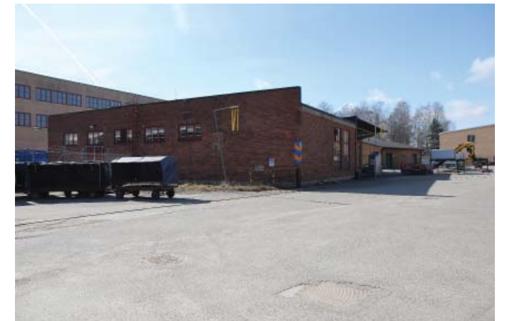
F.d. maskinsnickeri, östra och norra fasaden. Foto 2017
