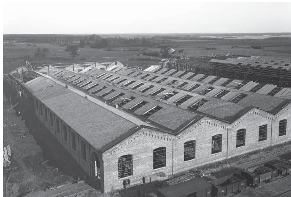
Vagnverkstadens karaktäristiska takkonstruktion under uppförande. Foto 1907. Källa Örebro läns museum.
