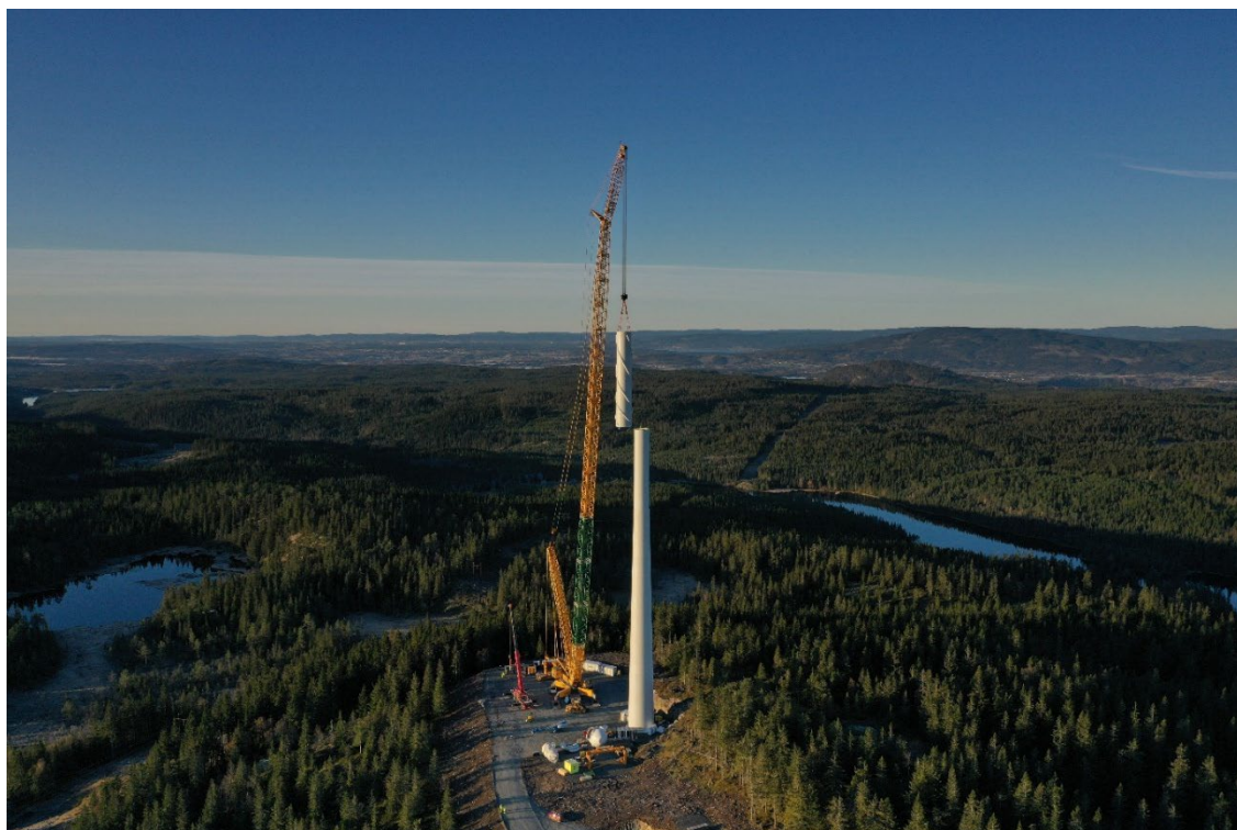
Figur 12. Exempel: Kranplats och montering av torndelar till vindkraftverk. Foto: Odal Vind.
