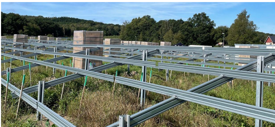
Figur 6. Exempel på markställningar.
