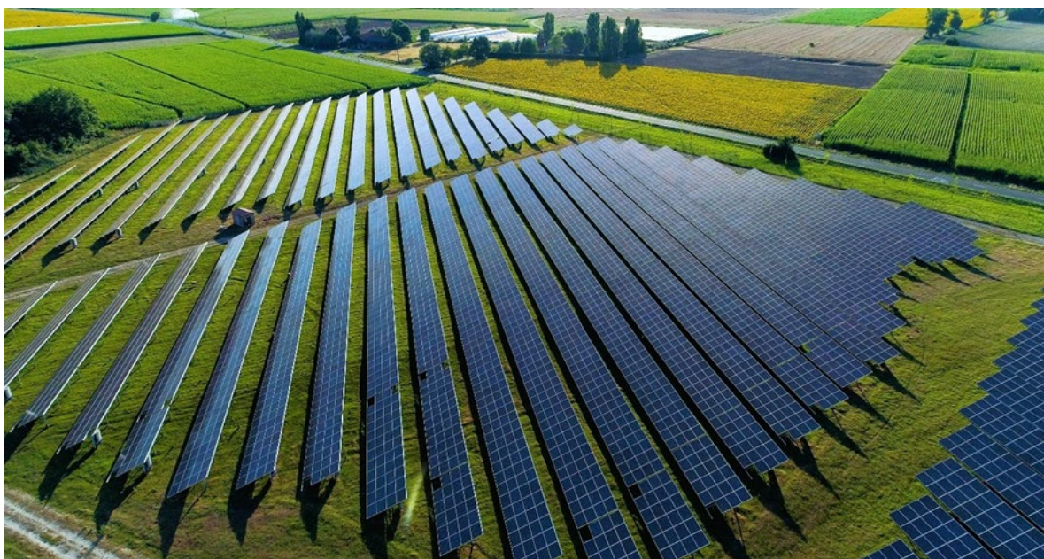
Figur 5. Exempel på solcellspaneler
