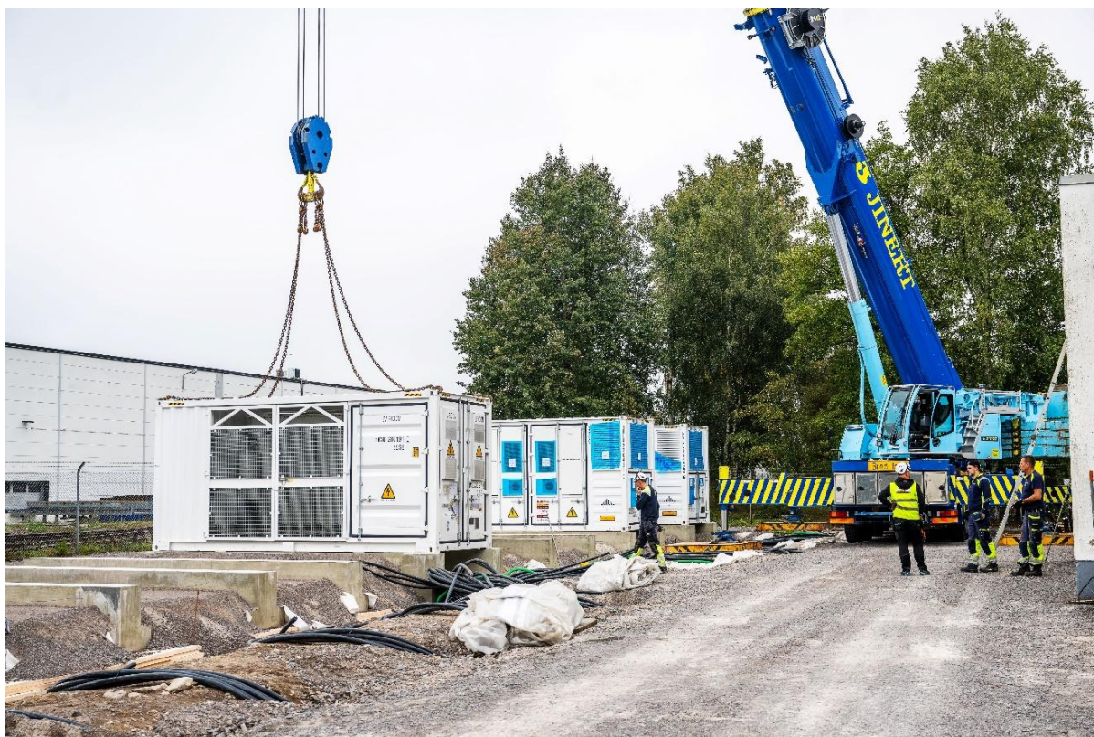
Figur 19. Battericontainrar lyfts på plats på betongfundament.
