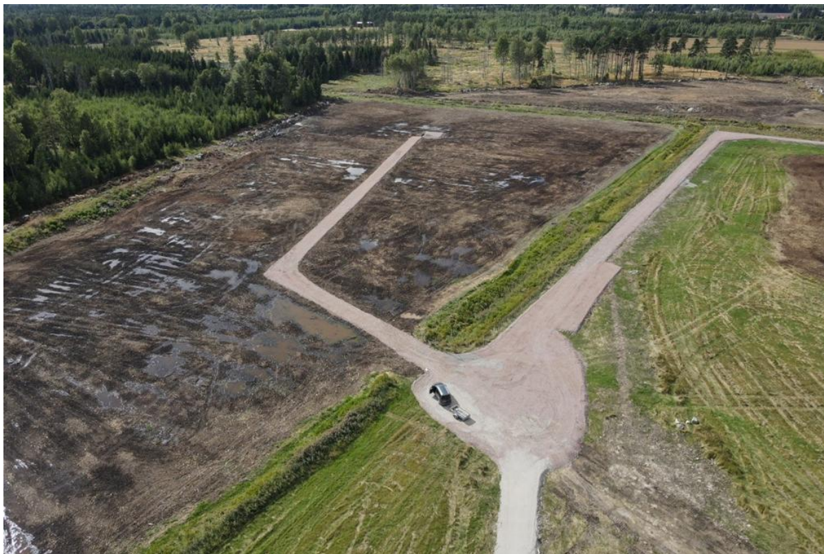
Figur 29. Solcellspark under konstruktion. Till höger i bild har marken brukats som jordbruksmark och till vänster som skogsmark. Byggvägar fram till transformatorer har anlagts.
