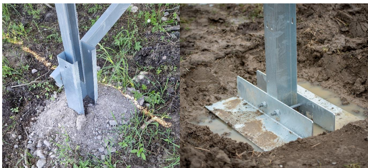
Figur 10. Stålprofiler som slagits/tryckts ner i marken vilket går bra i mark som inte är så stenig. Vänster: C-balk för fasta solpaneler. Höger: Kraftigare i-balk för enaxliga solföljare. Om marken har dålig bärighet kan det behövas stödplattor kring stålprofilen så att den inte sjunker ner i marken (höger). Om plattorna grävs ner under mark ökar motståndskraften mot vindlyft.
