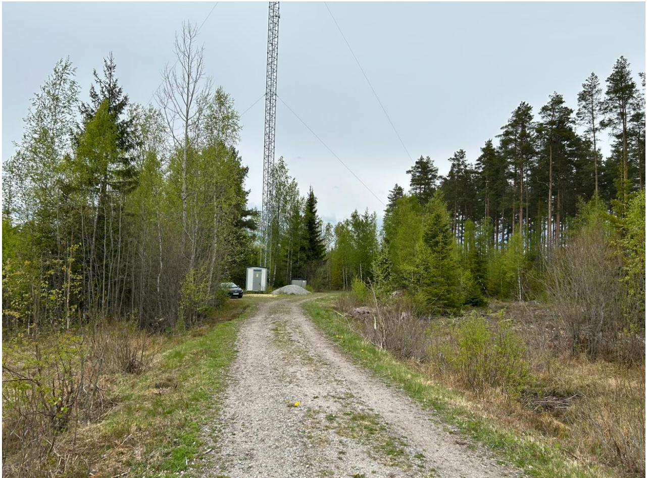
Figur 47. Foto 3 är taget strax norr om kraftledningsgatan. Beträktaren blickar norrut mot befintlig mast.
