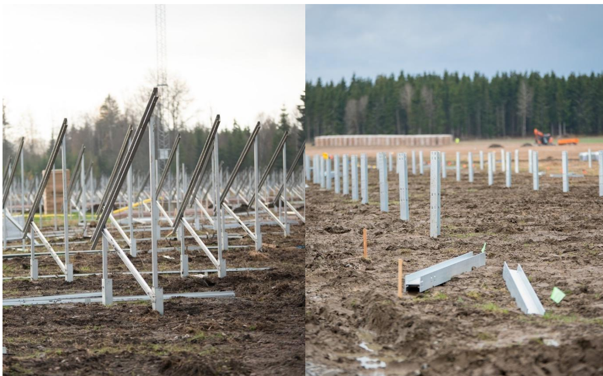
Figur 13. Vänster: Fasta markställningar uppställda i väntan på att solcellsmodulerna ska monteras, bild från Kungsåra solcellspark utanför Västerås. Höger: Markställningar för enaxliga solföljare uppställda i väntan på att solcellsmodulerna ska monteras, bild från Medinge solcellspark utanför Örebro.
