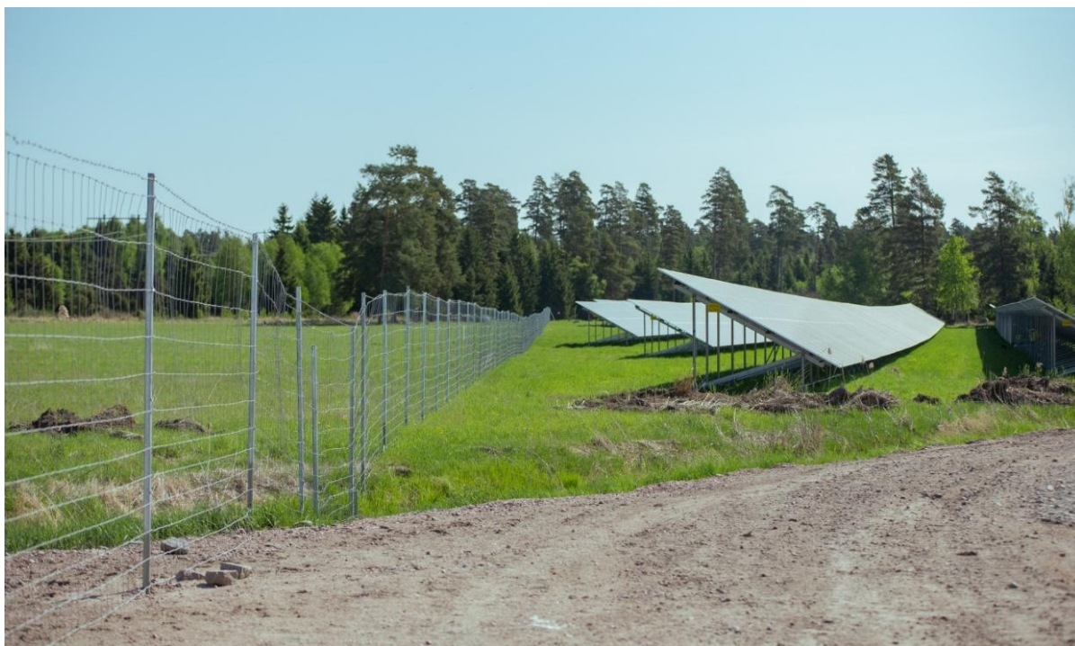
Figur 35. Exempel på synintryck av Helios solcellspark i Kungsåra, Västerås.
