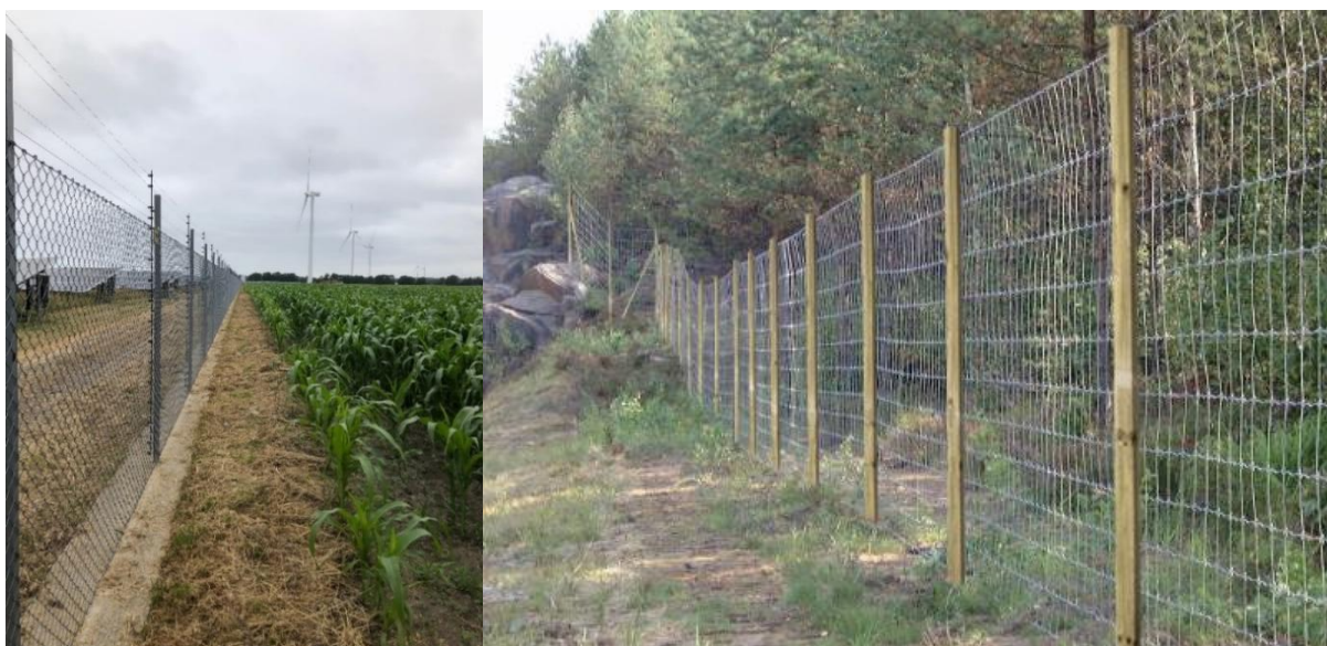
Figur 6. Vänster: Exempel på utförande av industristängsel med invändigt överklättringsskydd i form av eltrådar. Höger: Exempel på viltstängsel på trästolpar och utan överklättringsskydd.
