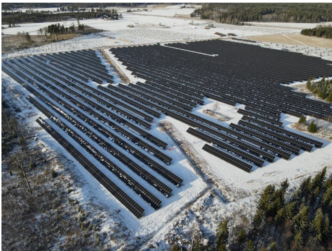
Figur 4. Drönarfoto på Kungsåra solcellspark utanför Västerås under byggnation i februari 2023. På bilden framgår tydligt hänsynsramarna kring diken och åkerholmar.
