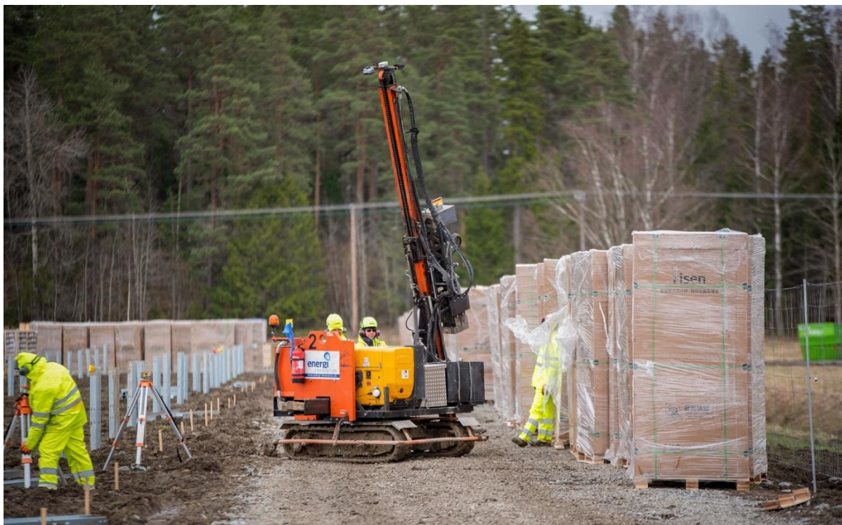
Figur 8. Exempel på pålningsmaskin på larvfötter för installation av pålar för stängsel och markställningar. Bild från Medinge solcellspark utanför Örebro.
