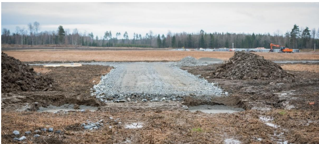
Figur 17. Exempel på en grävd grund för en transformator och en anlagd grusväg. Grundläggningen för transformatorn utgör de två groparna hitom grusvägen i bild.
