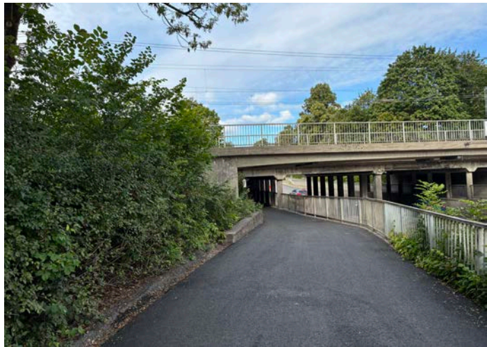
Bild 4. Gc-stråket under järnvägen vid Hagapassage under järnvägen är enkelriktat, men efterföljs inte. Siktlinjen är bruten och passagen är trång. Vegetationen i anslutande slänter och refuger är ruff och bidrar till otrygghetskänslan. Kopplingen till Eugenparken är svag här.
