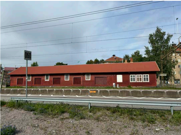
2. Godsmagasinet med skjutdörrar.
