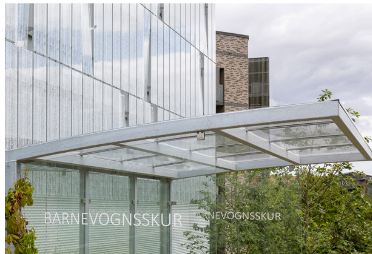
Bild 2. Cykeltak Knarreborg, Hitsa, i nära anslutning till fasad visar hur viktigt det är med sikt genom taket och från fönster, att beakta i husnära lägen.
