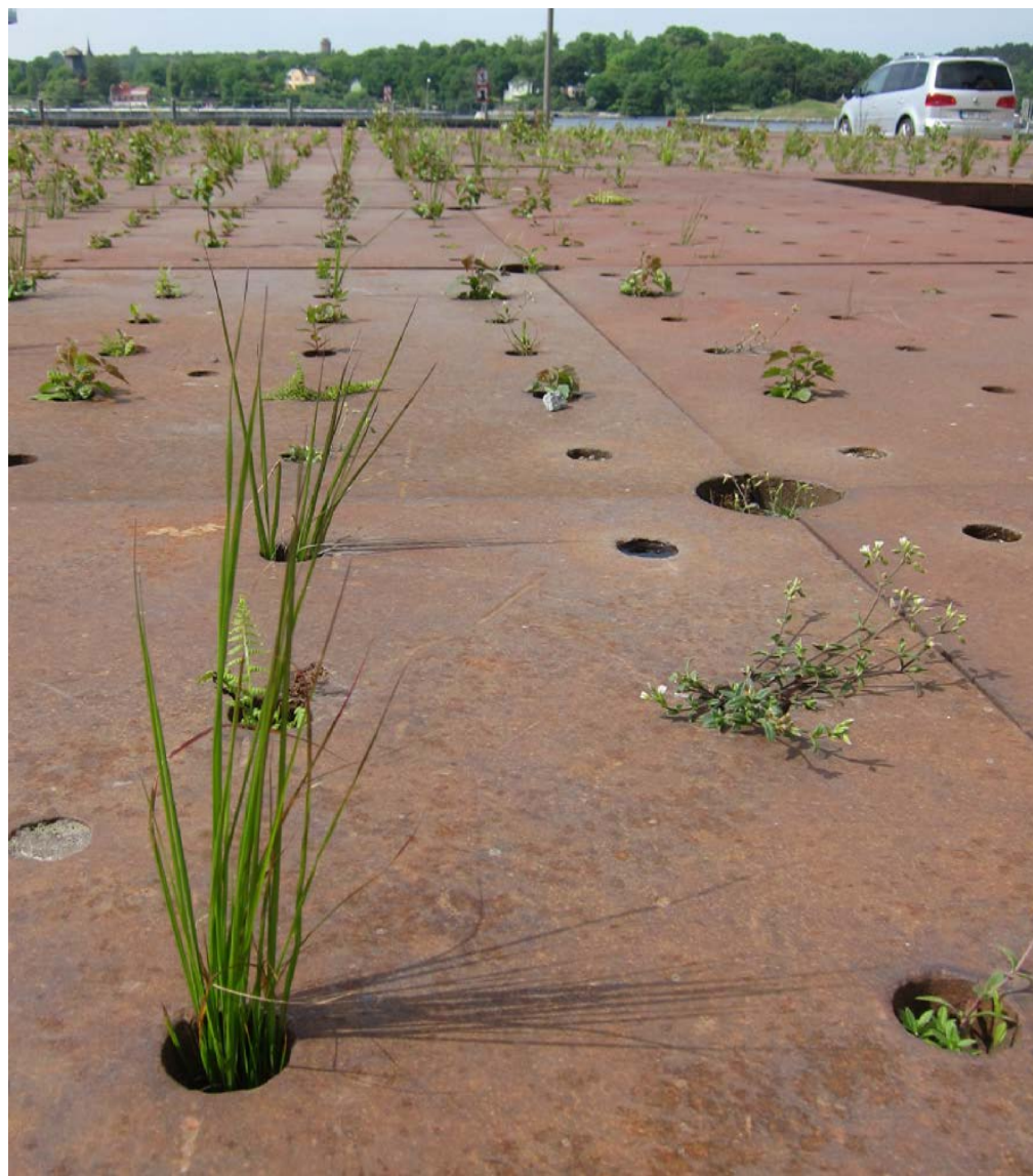
Exempel p-platser på påldäck i plåt, Stockholm, där plattor kan demonteras för att drifta underliggande mark.
