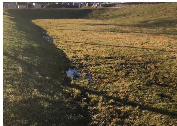
Bild 1. Översvämningsytan har slänter mot banvall och mot Svartå Bangata. Ytans botten är flack. Den slås med slåttermaskin på sommaren och är möjlig att gå på under största tiden mellan större regn.
