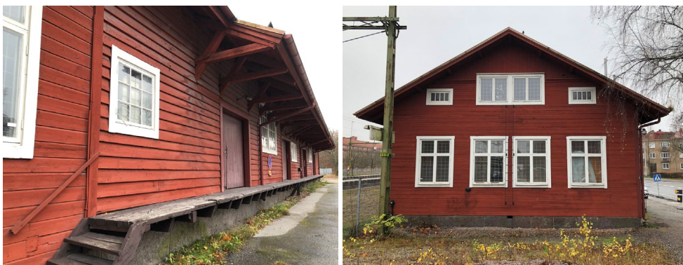
På godsmagasins västra längsida syns skillnaderna i panel och fönstertyper mellan den norra och södra delen av byggnaden. Bilden till vänster visar godsmagasinet norra gavel med korspostfönster och spontpanel. Bild: Örebro kommun.
