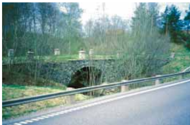
På flera håll finns äldre vägsträckningar bevarade intill den nuvarande vägen, som här vid Emma där även den gamla stenvälsbron från 1766 finns kvar.
