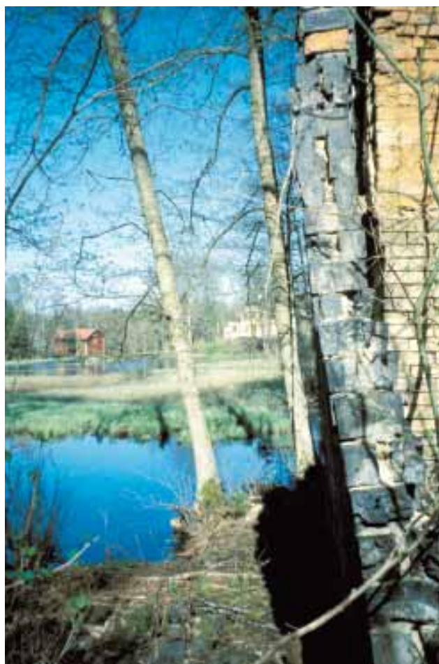
Ruinerna efter gjuteriet i Haddebo, vars väggar var murade med block av vällugnsslagg. I bakgrunden skymtar den nyuppförda herrgårdsbyggnaden vid Nedre Haddebo
