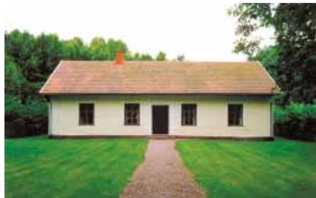
Lybby bönhus, även kallat Sionsborg
