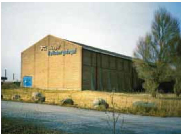
Hallsbergs tegelbruk från sydost
