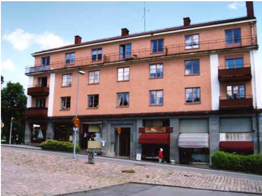
Kv Kronan 2, Östra Storgatan 2 - Stortorget 1
