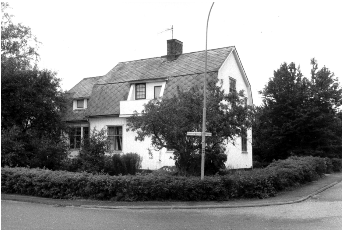
Skiffertak har i vissa trakter förr varit vanligt. Skifferplattorna lades omlott som fjäll. Liknande effekt kunde viss plåttäckning ge, t ex zinkplåt. Detta rutmönster efterliknades senare med kraftig takpapp.
