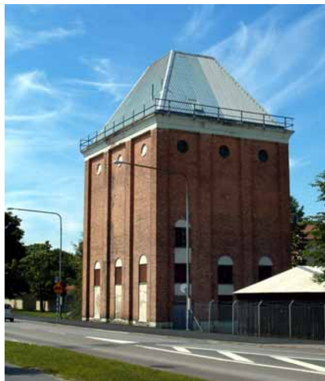
F d transformatorhuset
