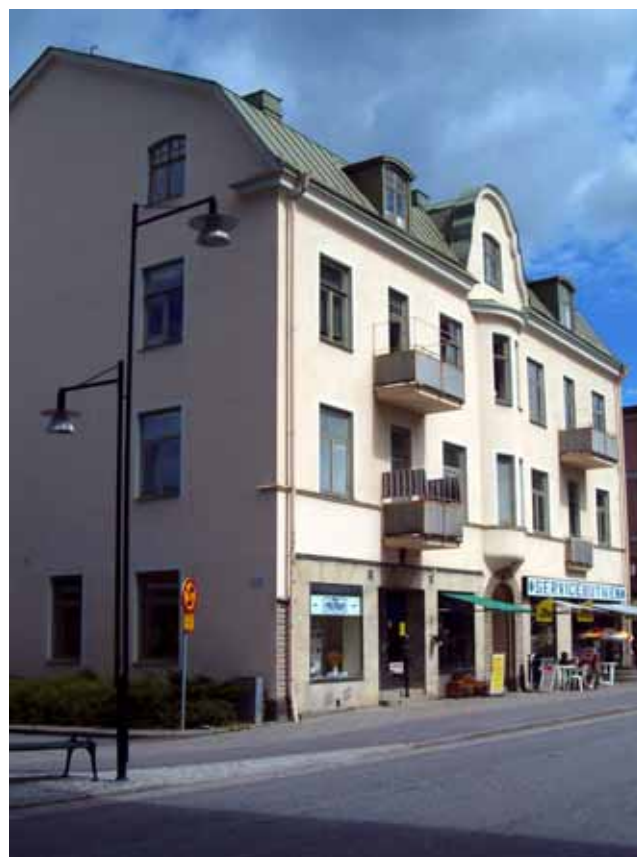
Västra Storgatan 4, kv Tacktorp 4
