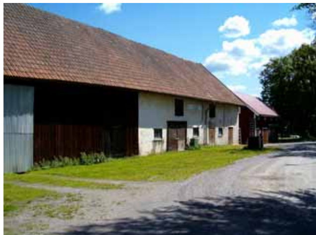
De kvarvarande ekonomibyggnaderna påminner om det jordbruk som tidigare bedrevs i området.
