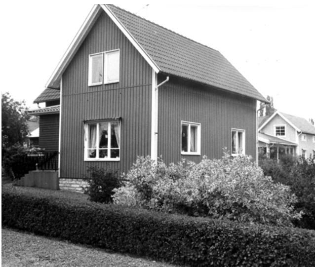
Två typer av fasadmaterial har använts för att försöka göra panelinklädda trähus ”underhålls- fria”: under 1950-60-talen eternitplattor och från 1970-talet fasadplåt. Husen har med dessa nya ytskikt förlorat både skönhet och charm. Ägarna slipper måla men har i gengäld fått livlösa fasadytor. Jämför med bilden från det nybyggda Egnahem i bokens början.
