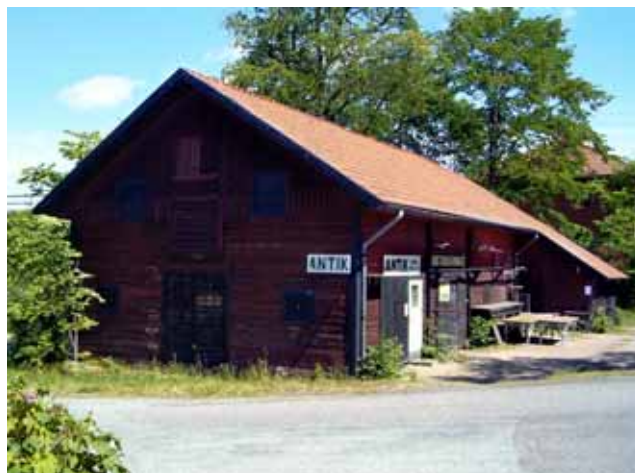
Magasinsbyggnad i trä, kv Höjden 8, Bergöös väg 2
