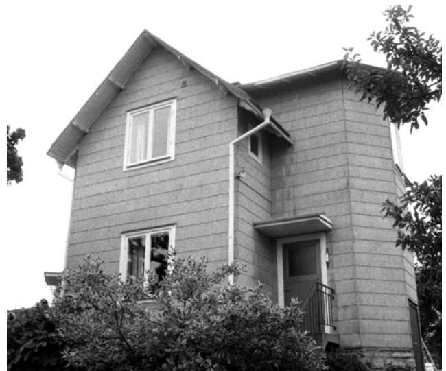
Två typer av fasadmaterial har använts för att försöka göra panelinklädda trähus ”underhålls- fria”: under 1950-60-talen eternitplattor och från 1970-talet fasadplåt. Husen har med dessa nya ytskikt förlorat både skönhet och charm. Ägarna slipper måla men har i gengäld fått livlösa fasadytor. Jämför med bilden från det nybyggda Egnahem i bokens början.
