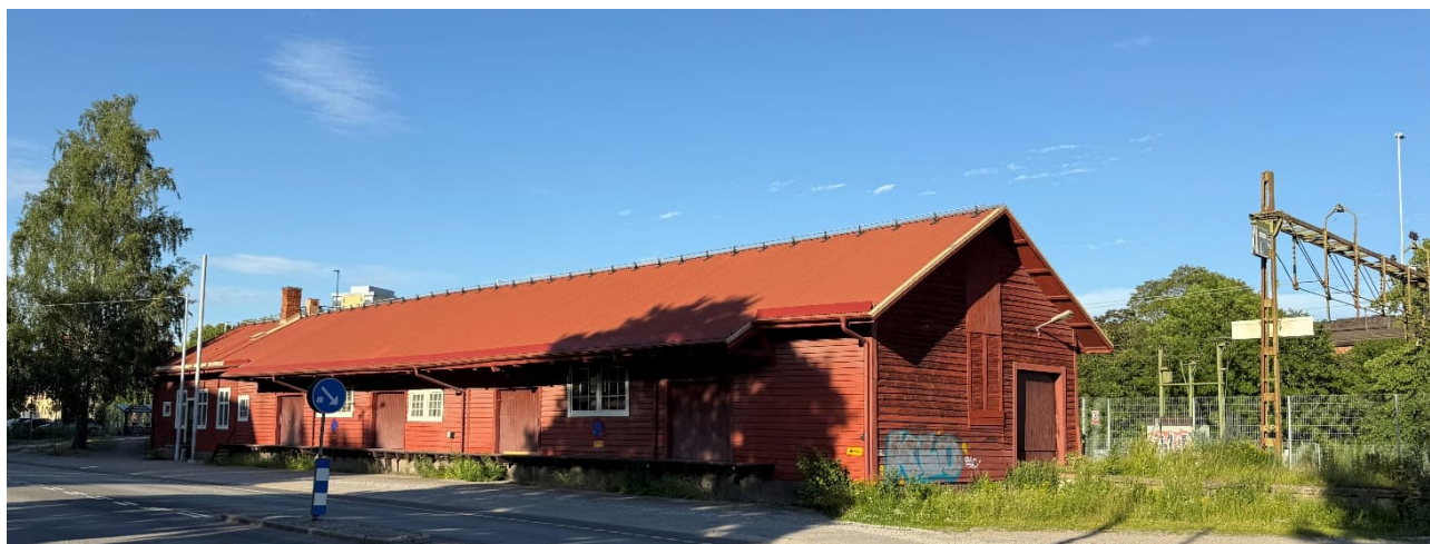
Figur 10. Godsmagasinet sett från vägen med rödslammad äldre fjällpanel och sockel av tuktad natursten. Byggnaden är klassad som blå (särskilt värdefulla byggnader och områden som är mycket goda exempel på bebyggelse utifrån tid eller stilepok).
