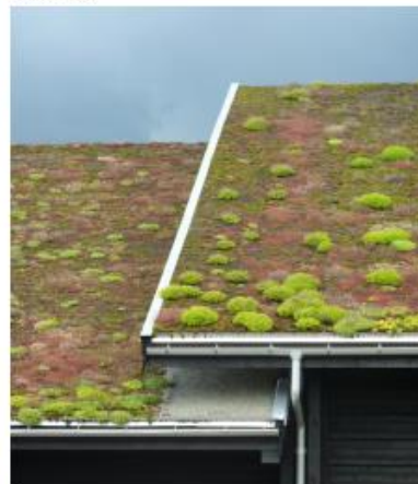
Figur 5-4 Exempel på gröna tak. TV: Takträdgård med vegetation i olika nivåer. TH: Ett grönt tak med tunn matta av torktåliga växter. Bild hämtad från SVOA (2025).
