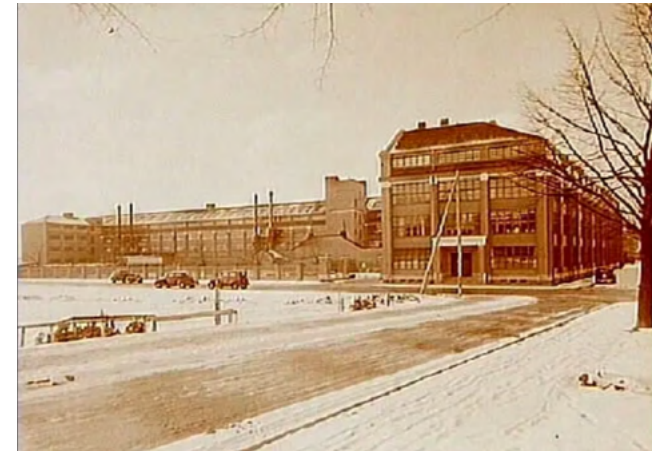
Gårdsfasaden fotograferad 1939 - tillbyggd mot öster och söder, samt mot gården.
