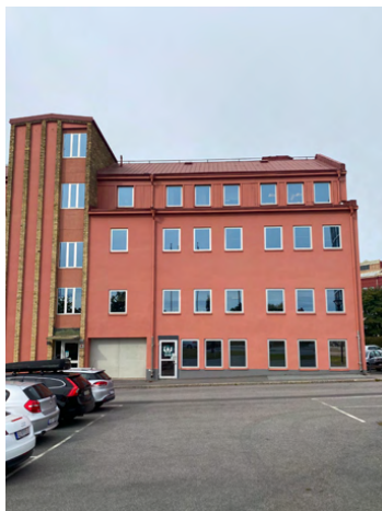
Kontorshus i vinkel mellan Östra Bangatan och Fabriksgatan.
