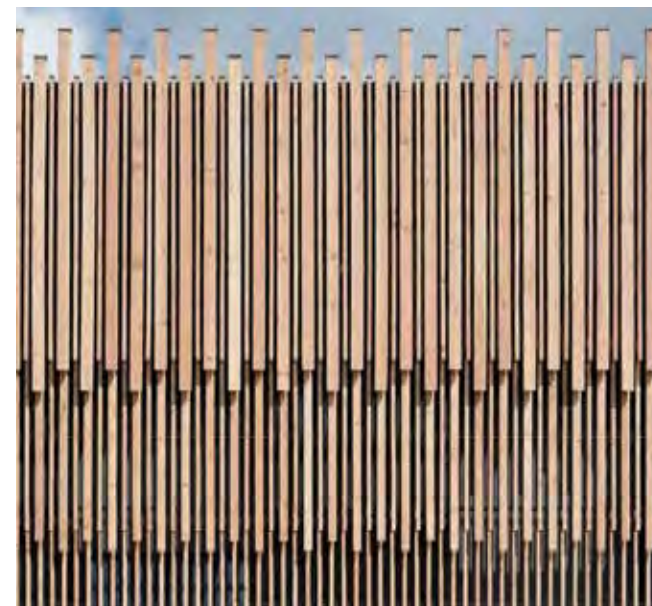
TRÄFASAD MED STÅENDE LÄKT, VÄRMEBEHANDLAD
