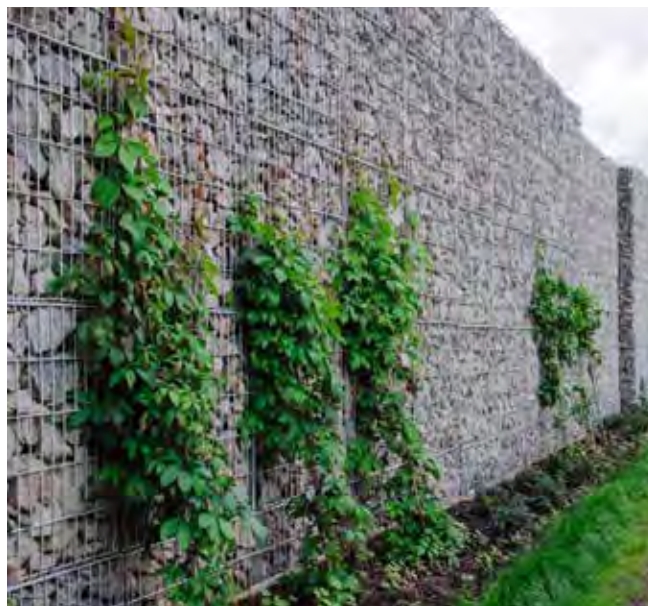
GABIONMUR SOM BAS
