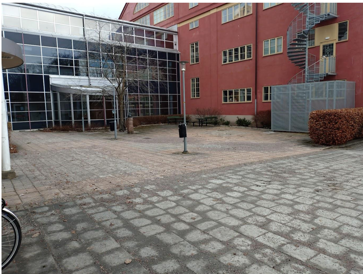
Bild 7: Befintlig entrébyggnad som planeras byggas om.
