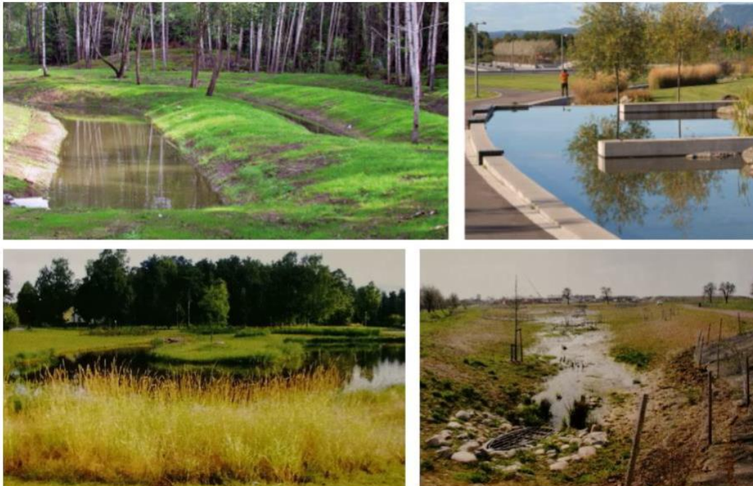
Figur 19. Exempel på dagvattendammar i olika miljöer. (Bildkälla: WRS, Svenskt Vatten).
