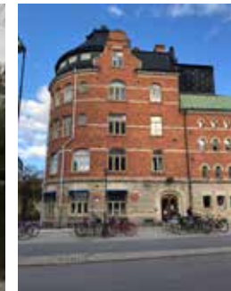
Gas- och elverkshuset i korsningen Vasagatan/Södra strandgatan
