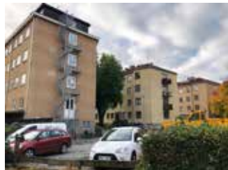
Parkering och hårdgjorda ytor mot Östra Bangatan.
