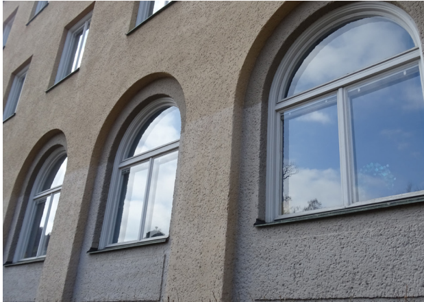
Rundbågade fönster med T-post, indragna i fasaden med puts i en grå kulör.
