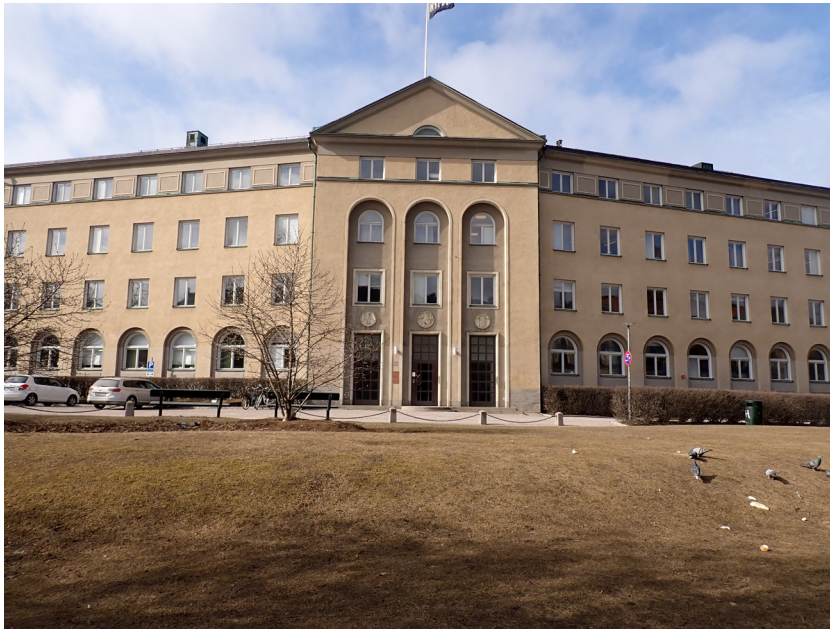
Symmetriskt fasaduttryck med markerad attika och mittrisalit med rundbågade lisener och fronton.
