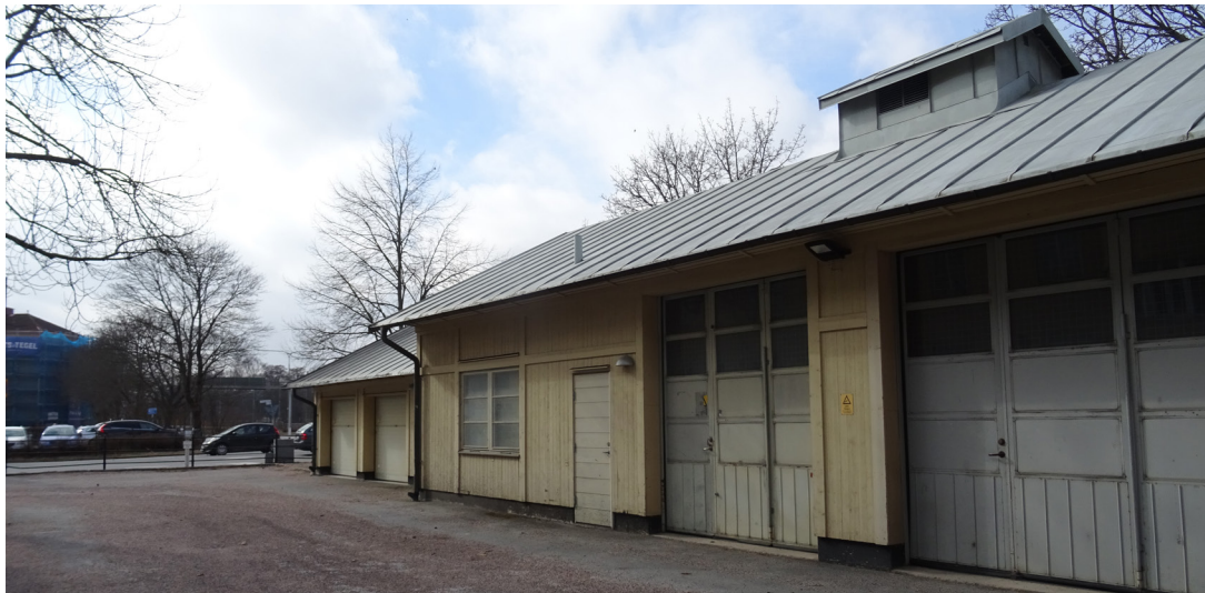
Garage- och förrådsbyggnaden.
