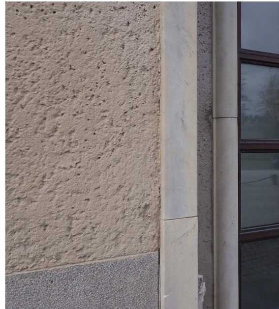
Sockel i granit, omfattningar i marmor och fasad i Örebroputs i ljus kulör.
