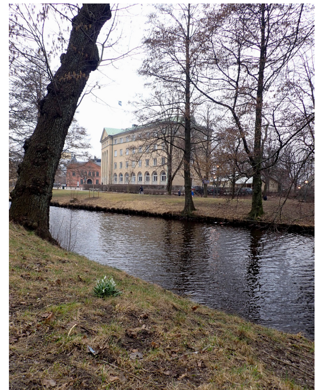
Nämndhuset med fronten mot årummet. Sett från Frimurareholmen.
