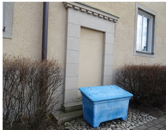
Igensatt ingång på byggnadens baksida.
