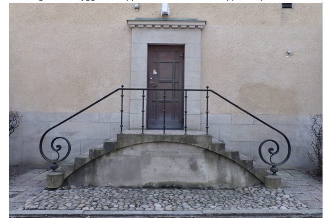
Norrgaveln med granittrappa, gjutjärnsräcke och dörrömfattning i marmor.
