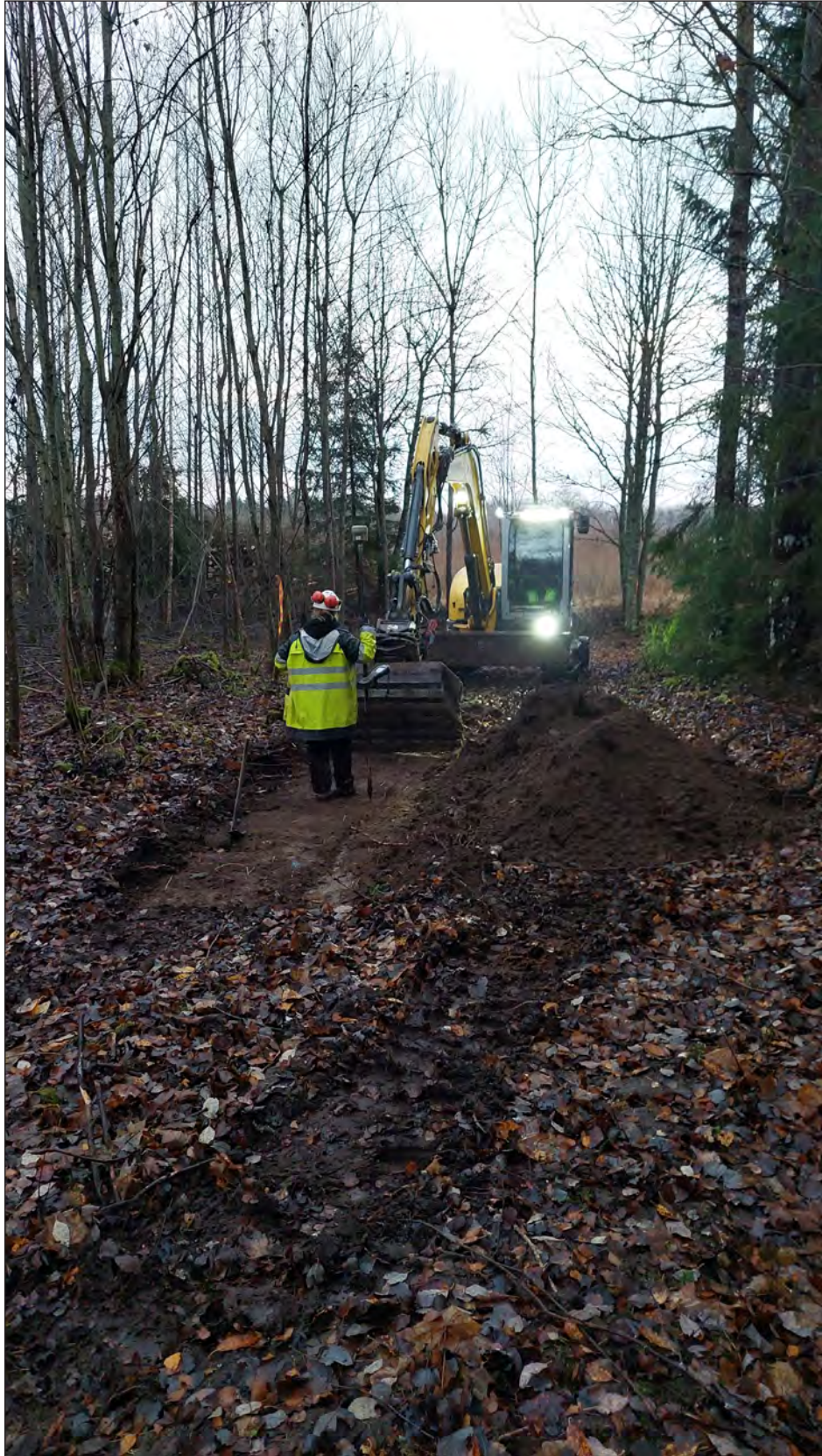
Figur 2. Schaktning i skogspartiet. Foto från väster.
